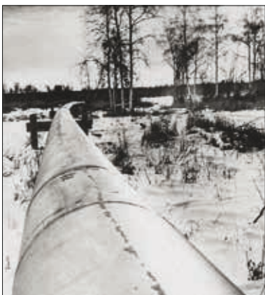
Таас-Тумус-Якутск. Газопровод на опорах.
