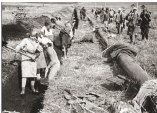
Строительство газопровода Саратов-Москва
