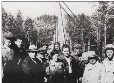
Участники прокладки Башкирских маршрутов
