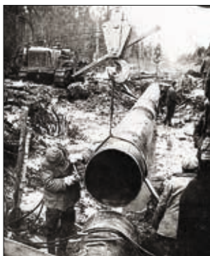
Газопровода «Кохтла-Ярве — Ленинград»
