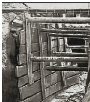
Устройство перехода под железной дорогой
