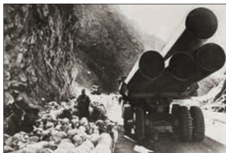
Разработка полков Доставка труб на трассу
