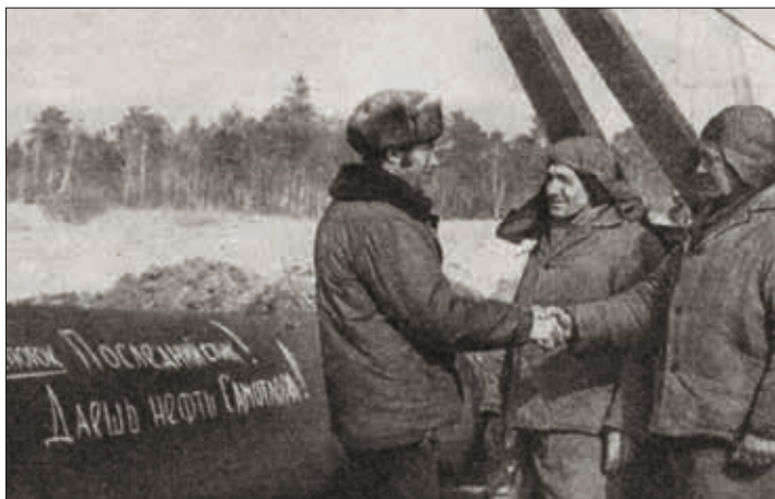
Прораб В. Слепнев поздравляет бригадира В. Попова и электросварщика А. Новикова (справа) с завершением последнего стыка на потоке № 12.
