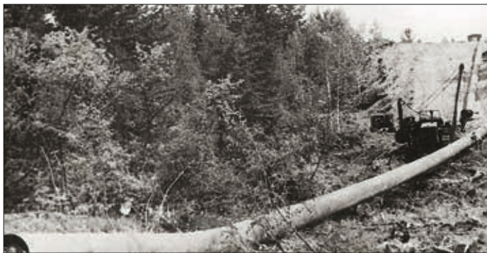
На строительстве продуктопровода Туймазы – Уфа
