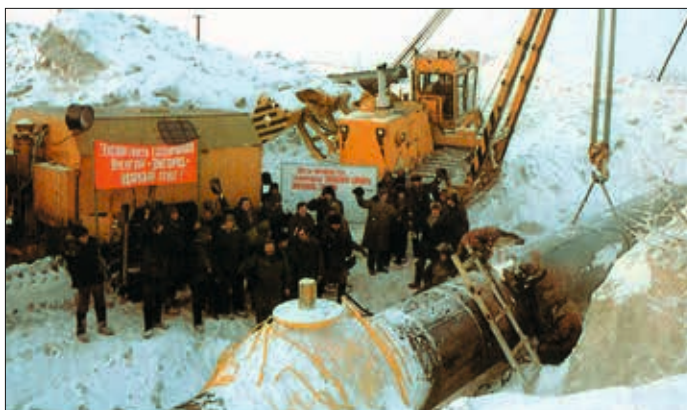
Митинг работников треста «Уренгойтрубопроводстрой», посвященный сварке первого стыка газопровода Уренгой — Помары — Ужгород на Уренгое. 1982
