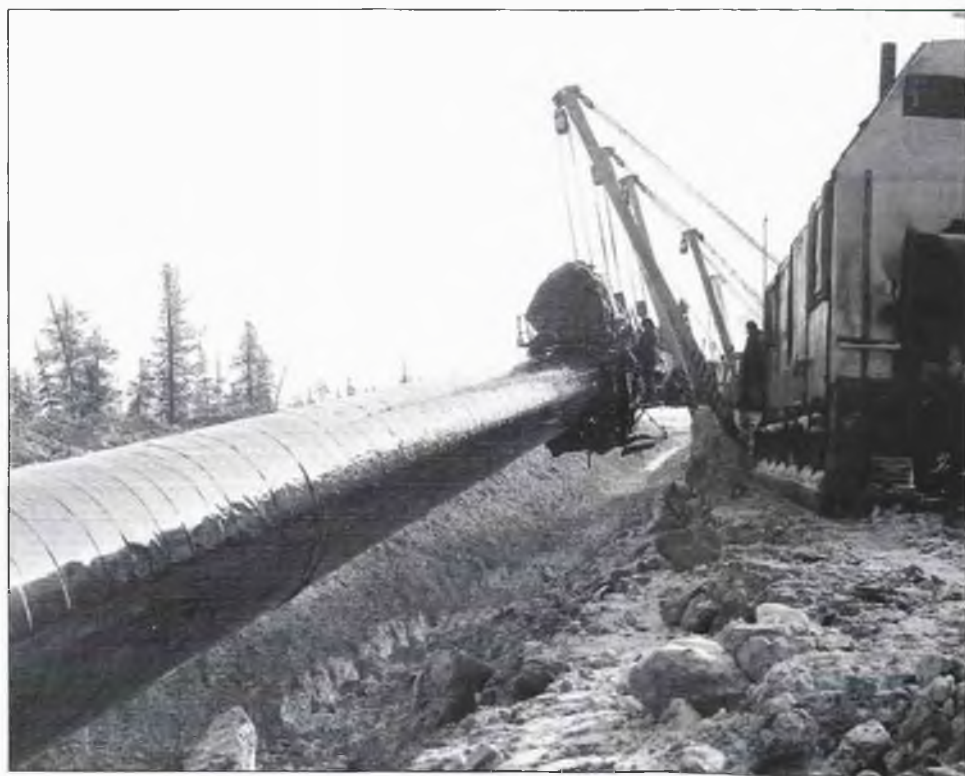
Через тайгу были проложены тыся- чи километров труб.
