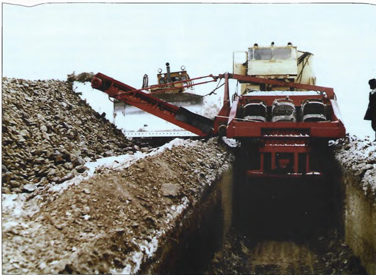
Роторный экскаватор в работе.
