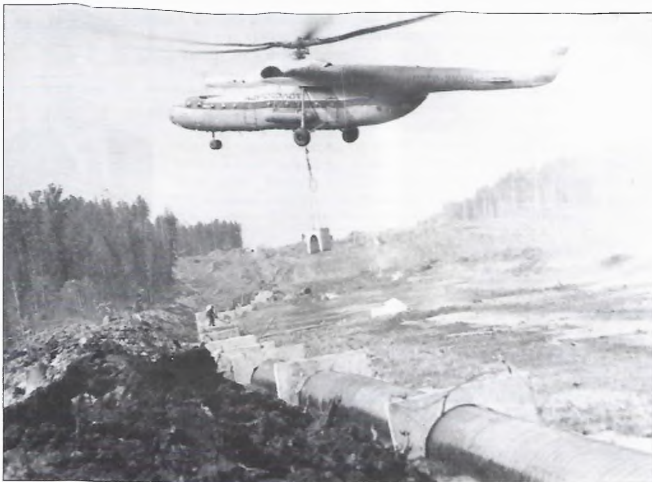
Установка пригрузов на трубопровод в Тюменской области.
