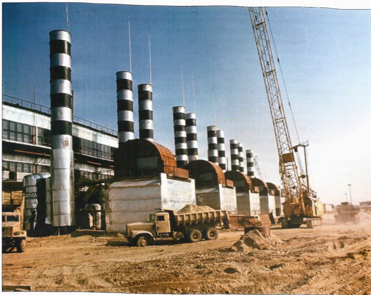
Строительство компрессорной станции в Тюмен- ской области.
