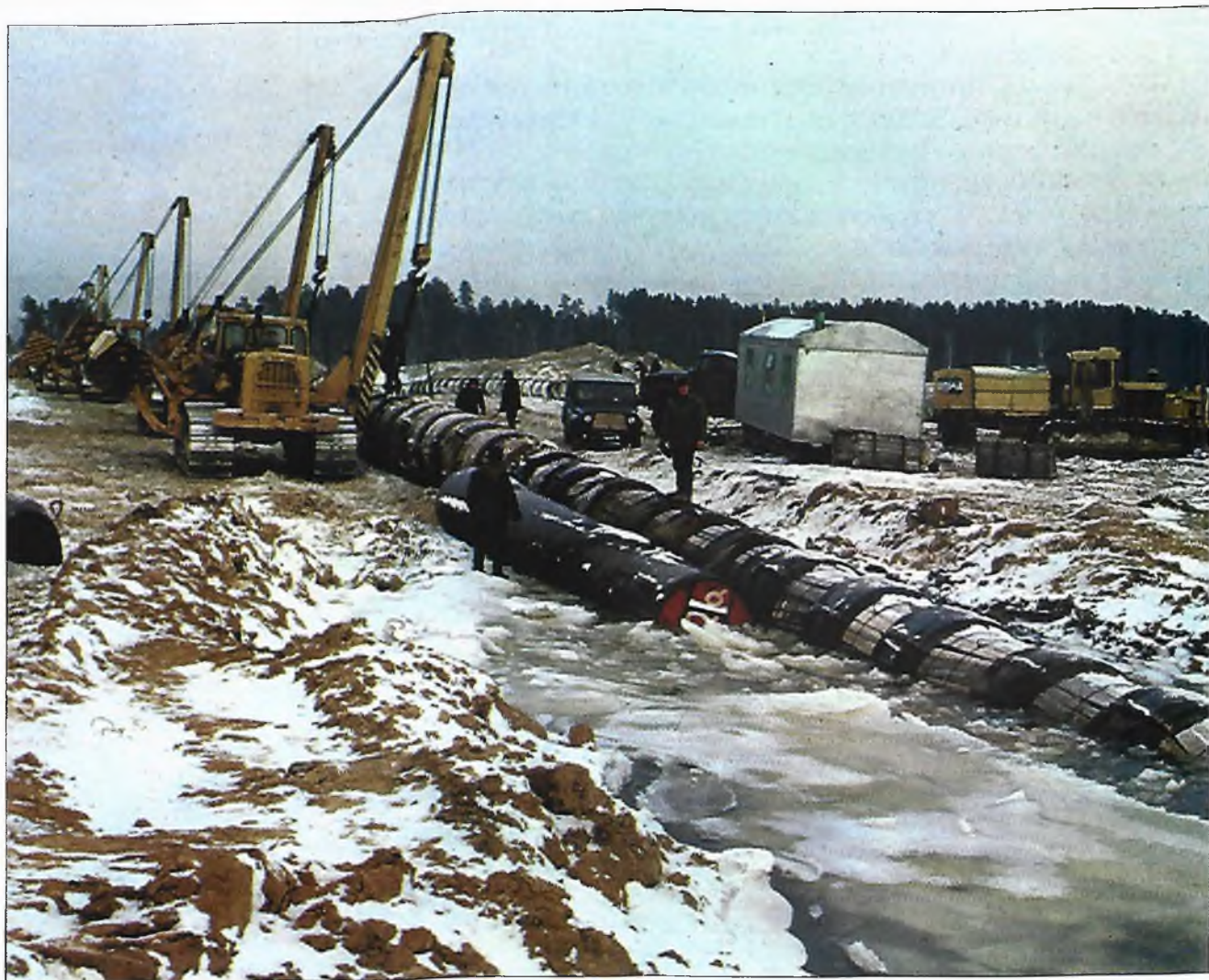
Укладка дюкера трубопровода через Волгу.
