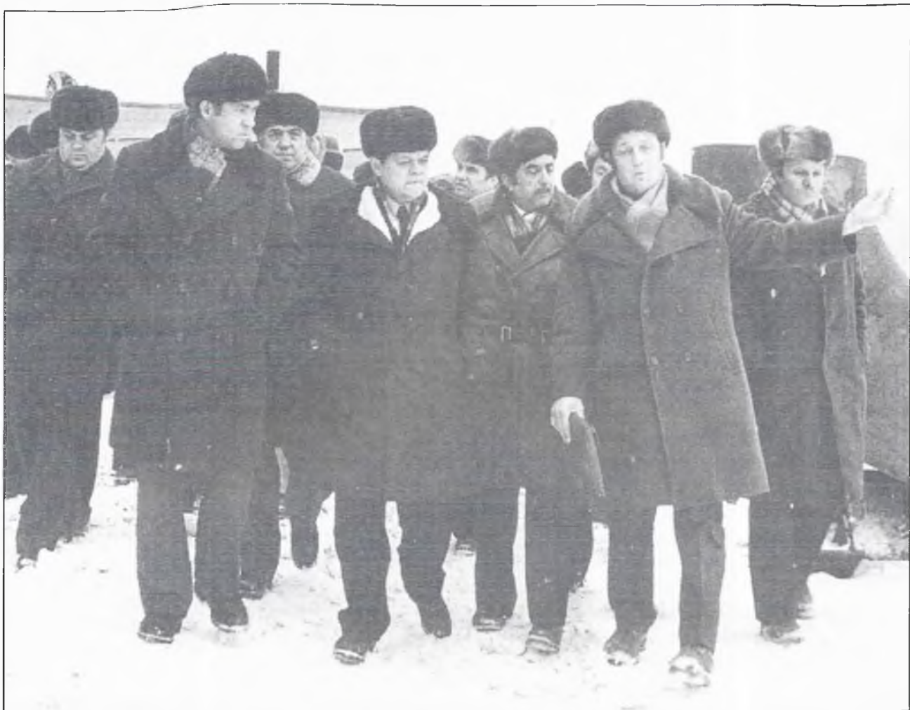
На компрессорной станции. Тюмен- ская область, 1972 г.
