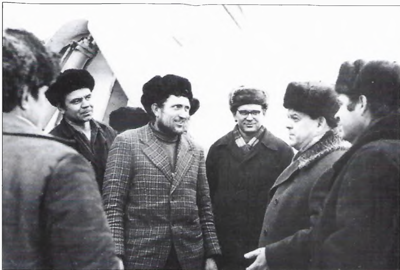
Б. Е. Щербина беседует со строителями газопровода Медвежье — Центр.
