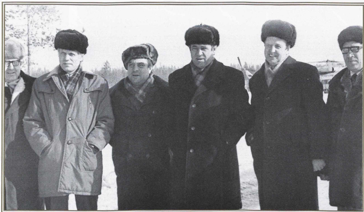
Слева направо: П.П. Шабанов, Н.И. Кизуб, Г.М. Мясников, В.Г. Чирсков, О.М. Иванцов, Н.И. Курбатов. На строительстве газопровода Вынгапур — Челябинск. Тюменская обл., 1978 г.
