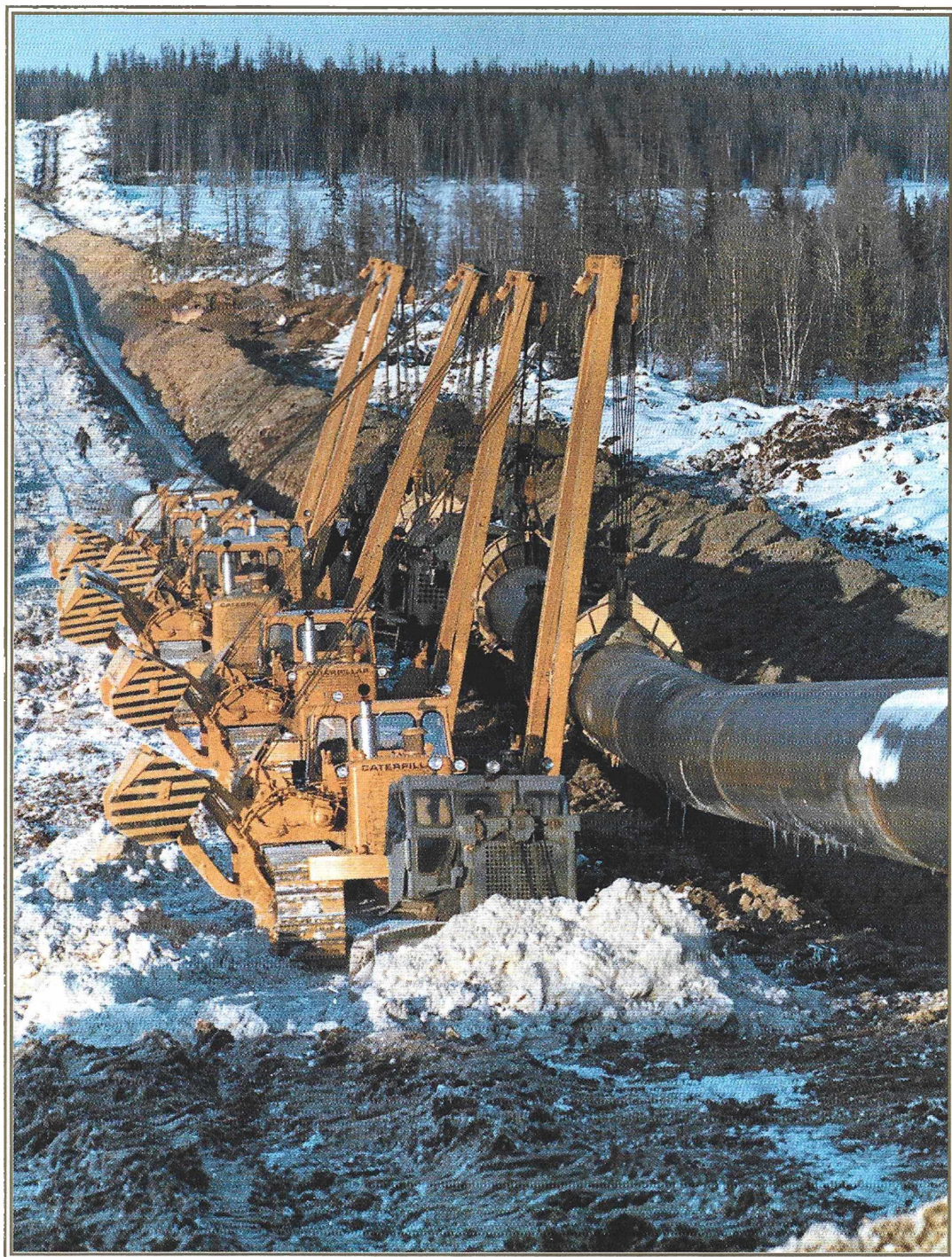
Изоляционно-укладочная колонна в работе. Тюменская обл., 1979 г.
