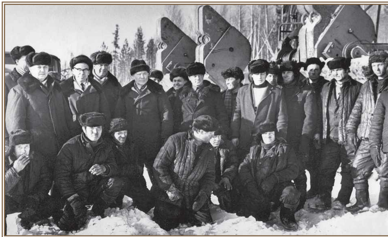
На строительстве нефтепровода Александровское – Анжеро-Судженск. Март 1972 г.
