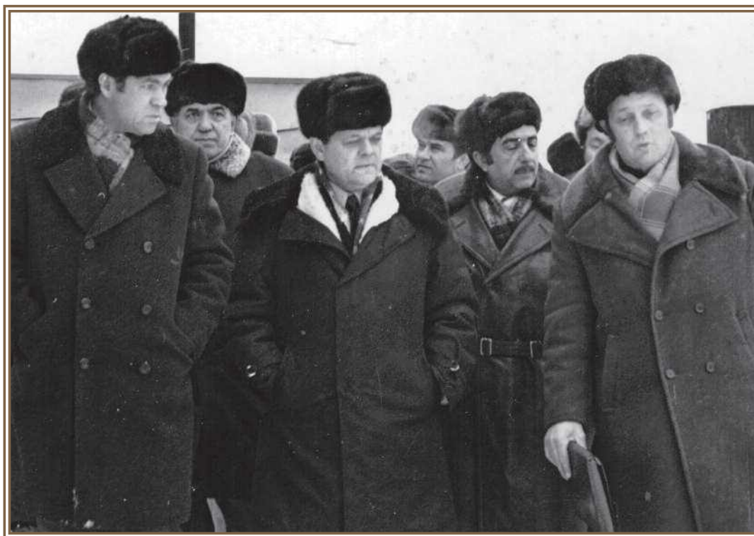
Министры Б. Е. Щербина и С. А. Оруджев на компрессорной станции «Приполярная». Тюменская область, 1977 г.
