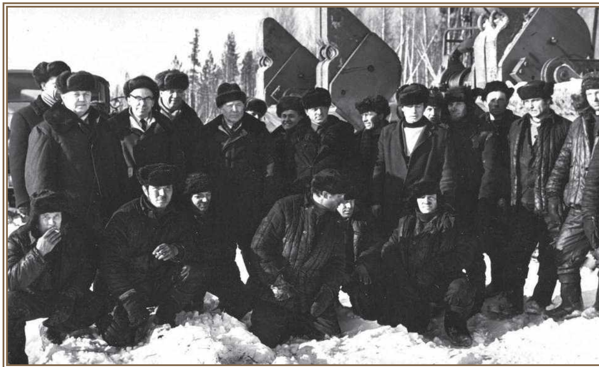
На строительстве нефтепровода Александровское – Анжеро-Судженск. Март 1972 г.
