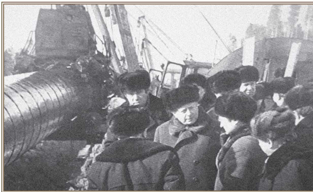
Заместитель председателя Совета Министров СССР В. Э. Дымшиц на строительстве газопровода Вынгапур — Челябинск. Тюменская обл., 1978 г.
