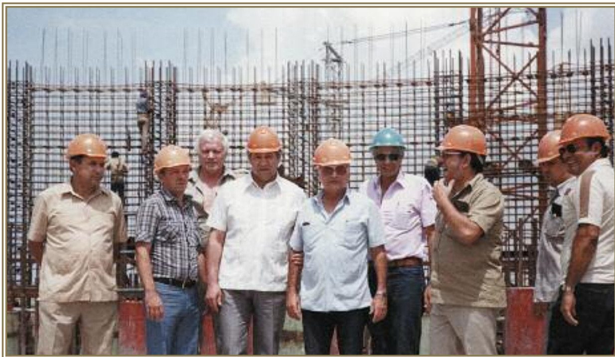
Посещение строящейся АЭС Хурагуа, город Сьенфуэгос, 1987 г.
