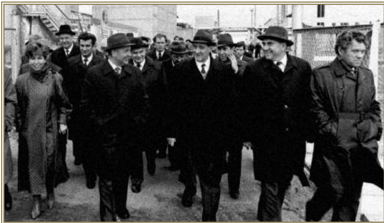
Руководители государства на строительстве газлифтной компрессорной станции. Самотлор, Тюменская обл., 1985 г.
