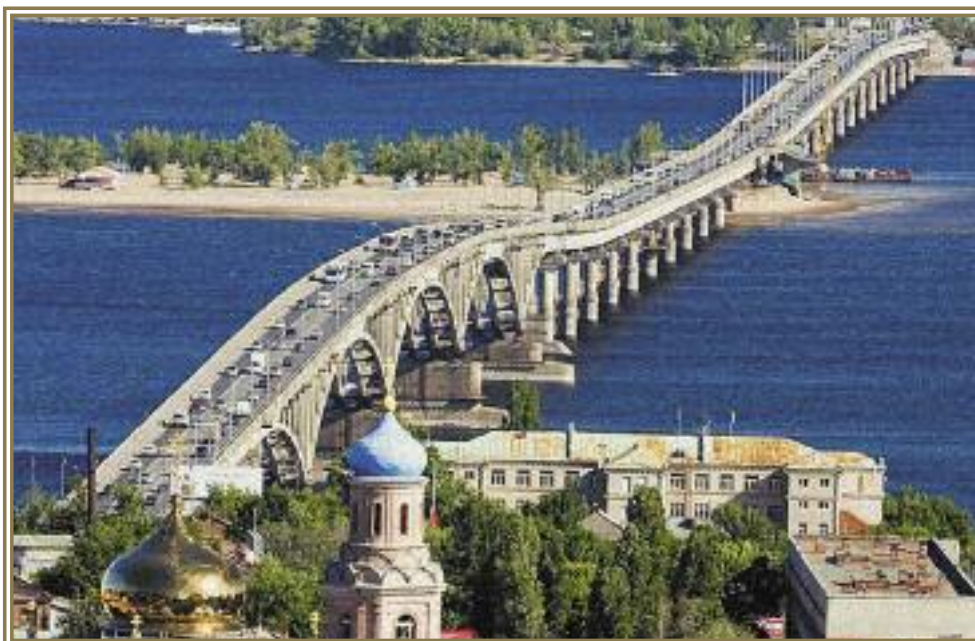
г. Саратов. Автомобильный мост.
