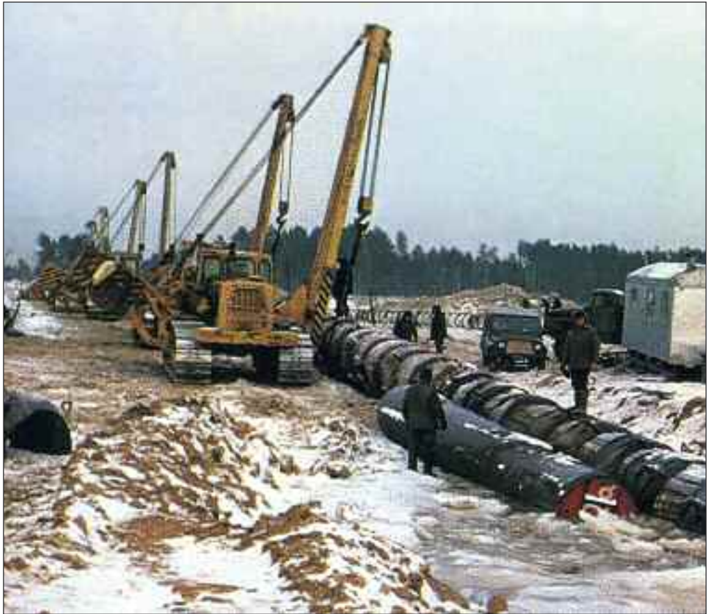
Монтаж трубы-дюкера для подводной укладки при переходе через Обь. 1978 г.
