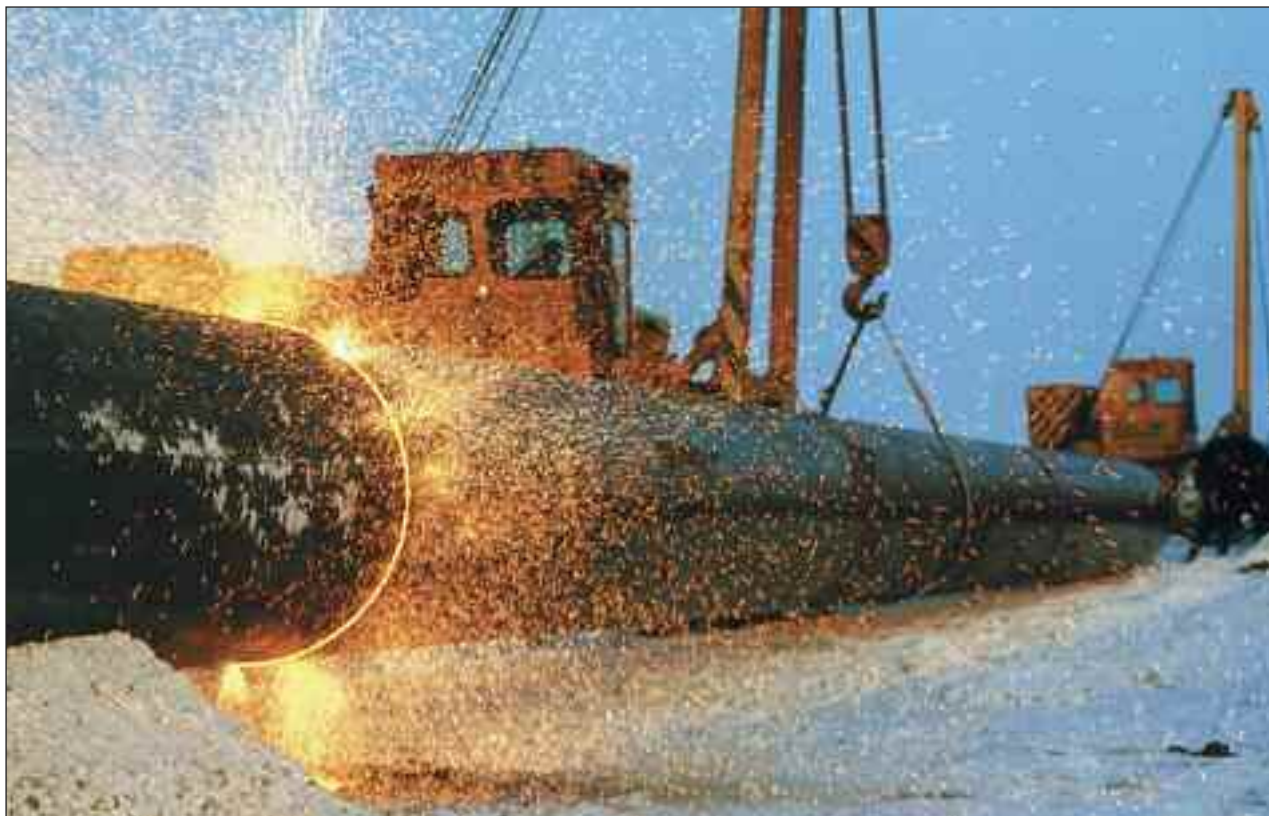
Знаменитый сварочный комплекс «Север-1» на трассе газопровода Уренгой-Челябинск. 1978 г.
