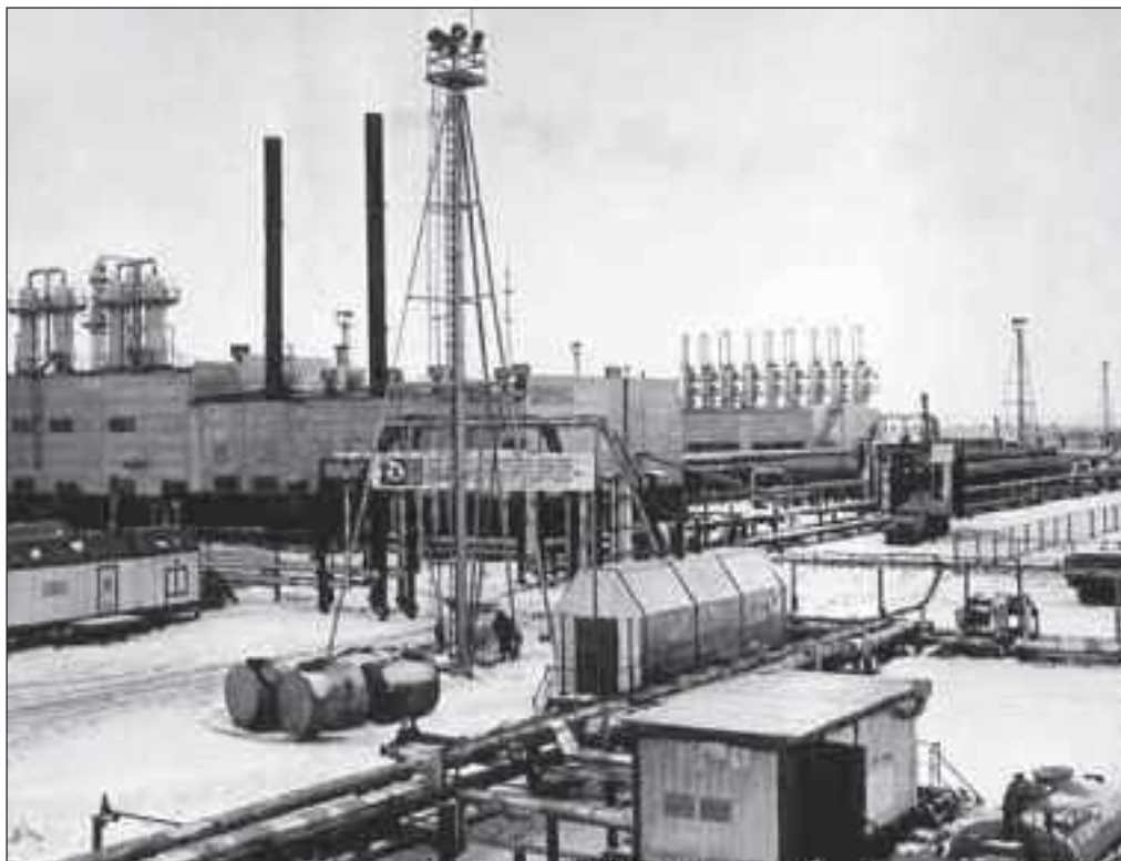
Установка комплексной подготовки газа. Ямбург, 1987 г.
