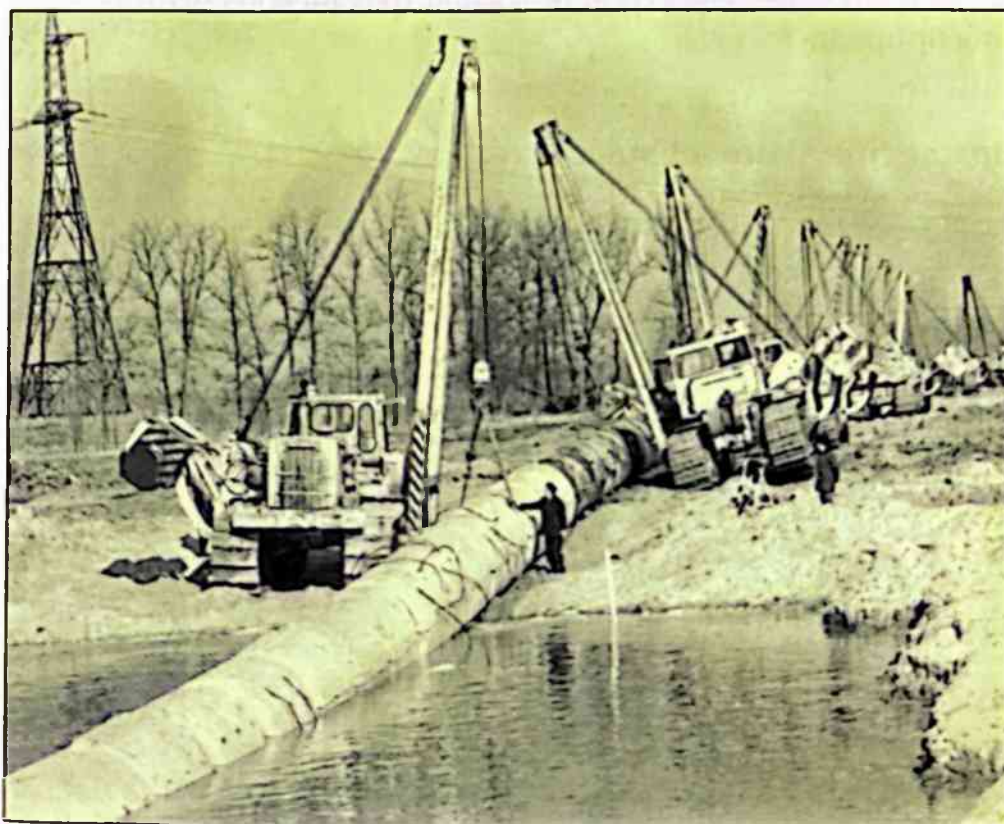
Прокладка дюкера через водную преграду.
