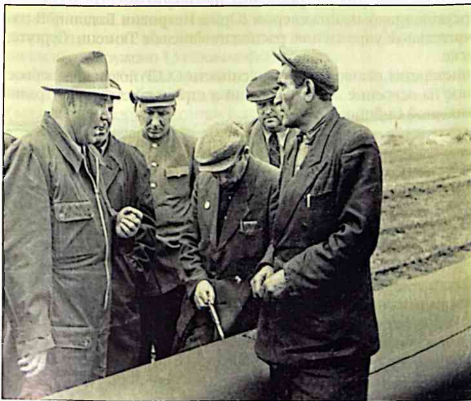
А.К.Кортунов со строителями на новой трассе газопровода.
