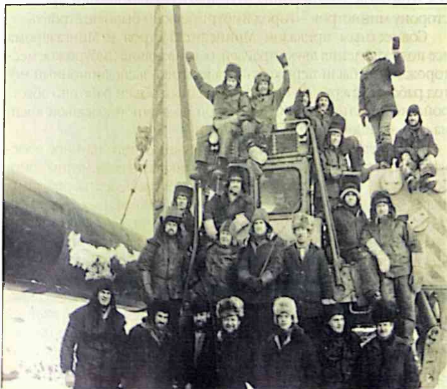
Сварочно-монтажная бригада Бориса Терещенко треста «Севертрубопроводстрой».
