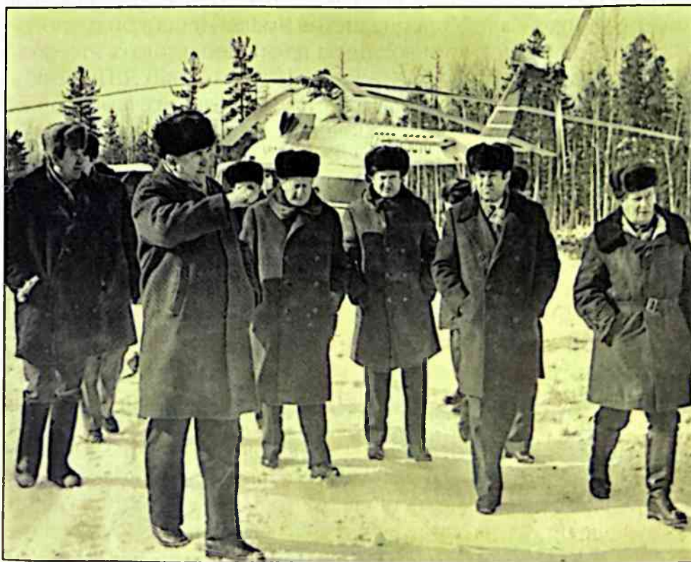
Заместитель Председателя Совета Министров СССР В.Э.Дымыщев на строительстве газопровода Уренгой – Челябинск. 1979 г.
