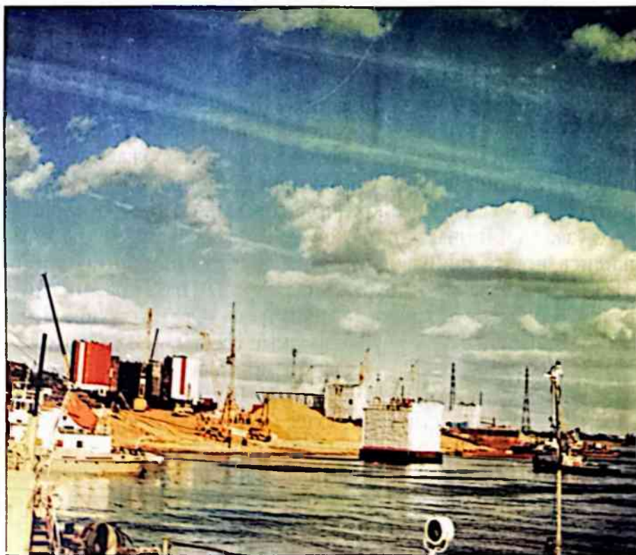
Монтаж супер-блоков для Ямбу́рга в г. Тюмени. 1985 г.
