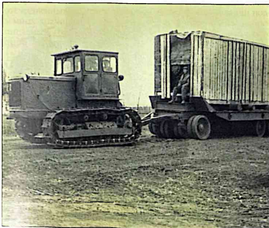
Доставка оборудования для строительства компрессорной станции.
