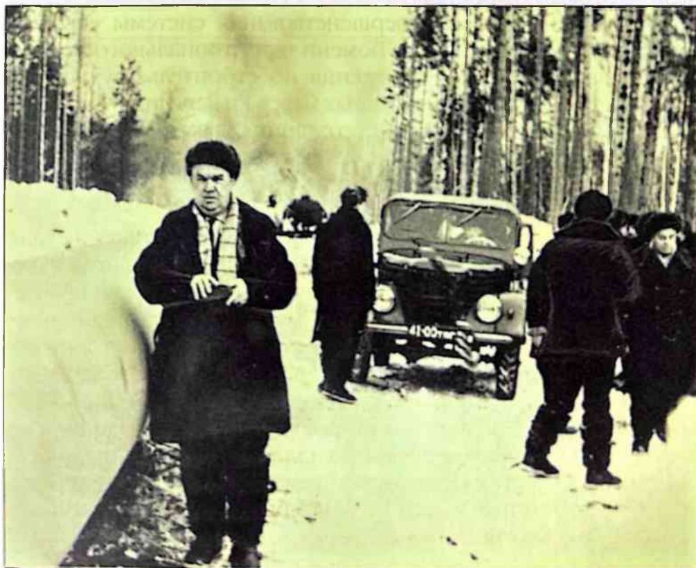
А. С. Барсуков на строительстве газопровода Игрим – Серов. 1964 г.
