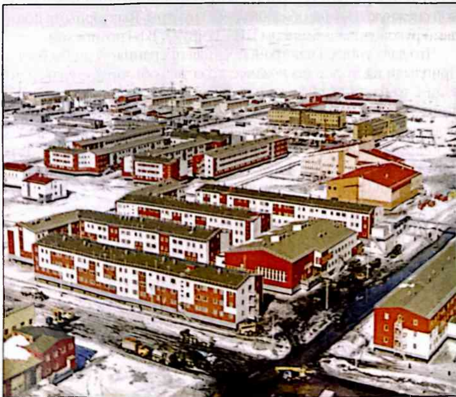
Вахтовый комплекс на Ямбурге.
