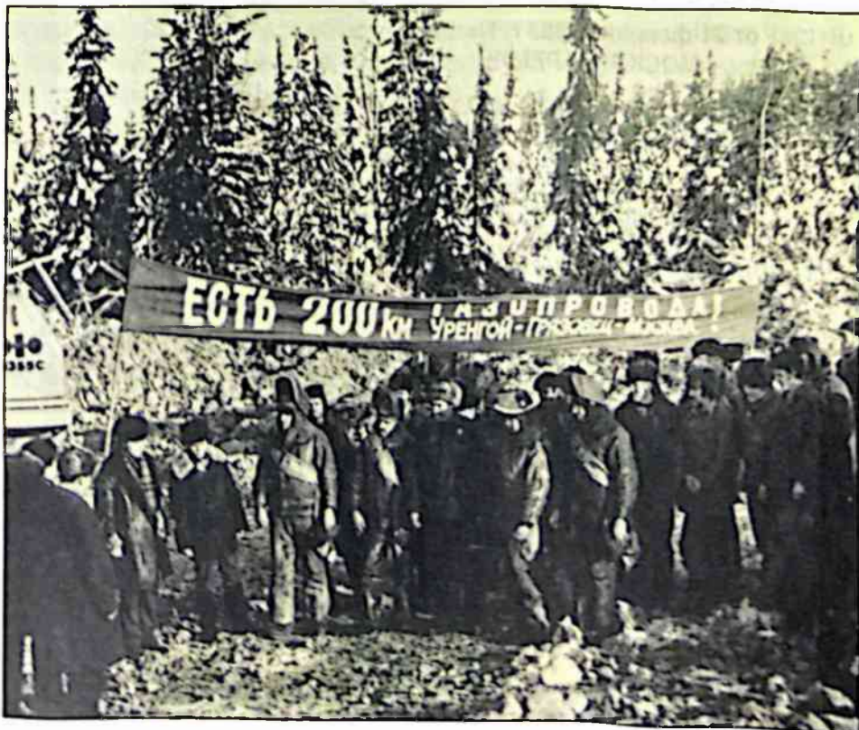
«Красный стык» на 200 км участке газопровода Уренгой – Грязовец, сваренный бригадой В. Н. Можарова треста «Приобьтрубопроводстрой».
