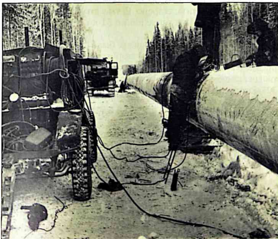
Ручная электросварка магистрального газопровода.
