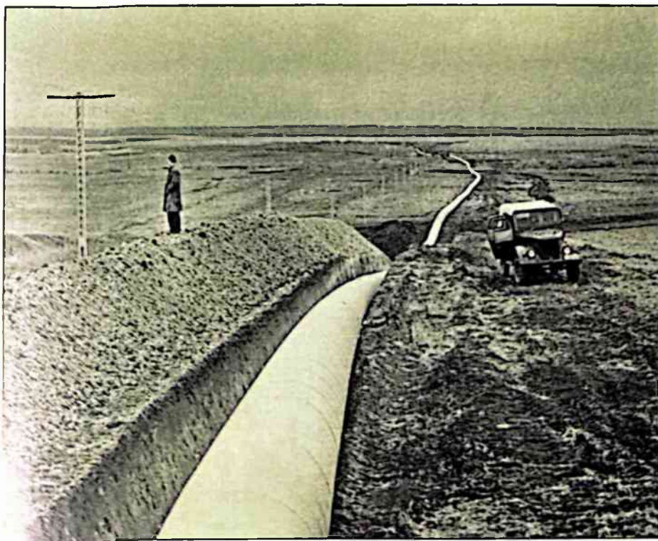
На многие сотни километров протянулась «нить» строящегося газопровода.
