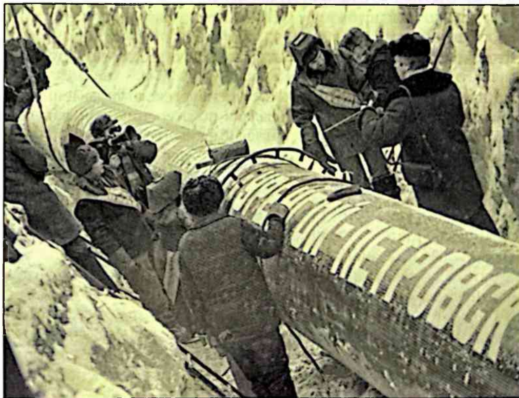
«Красный стык» на газопроводе Уренгой – Петровск.
