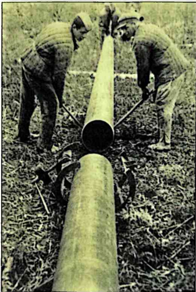
Центровка труб газопровода Саратов — Москва.
