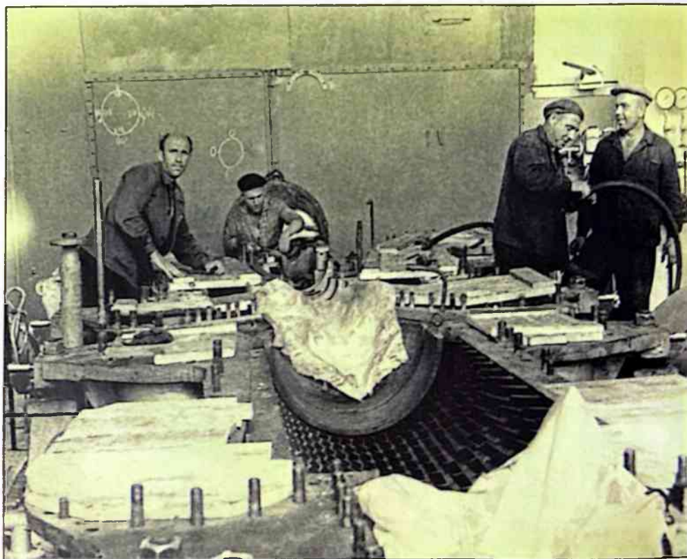
Монтаж осевого компрессора газовой турбины ГТ-700-4, Семилуки, 1959 г.
