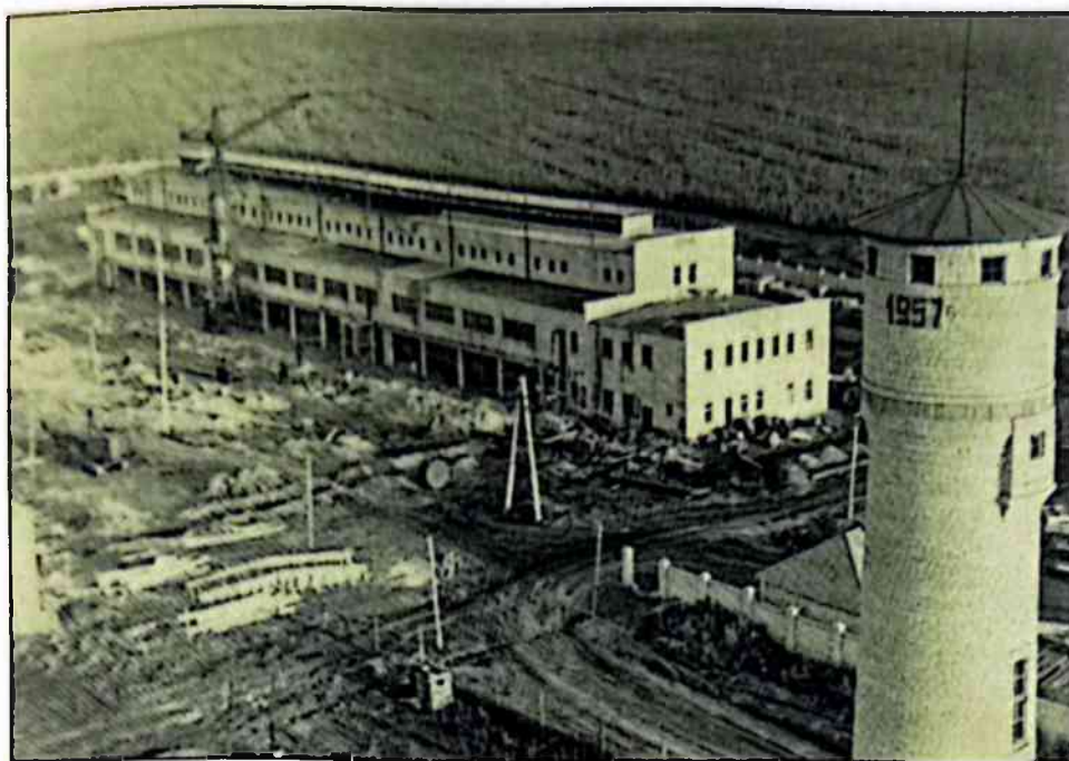
Создание первых районных управлений и строительство компрессорных цехов на газопроводе Ставрополь – Москва. Новопсков, 1958 г.
