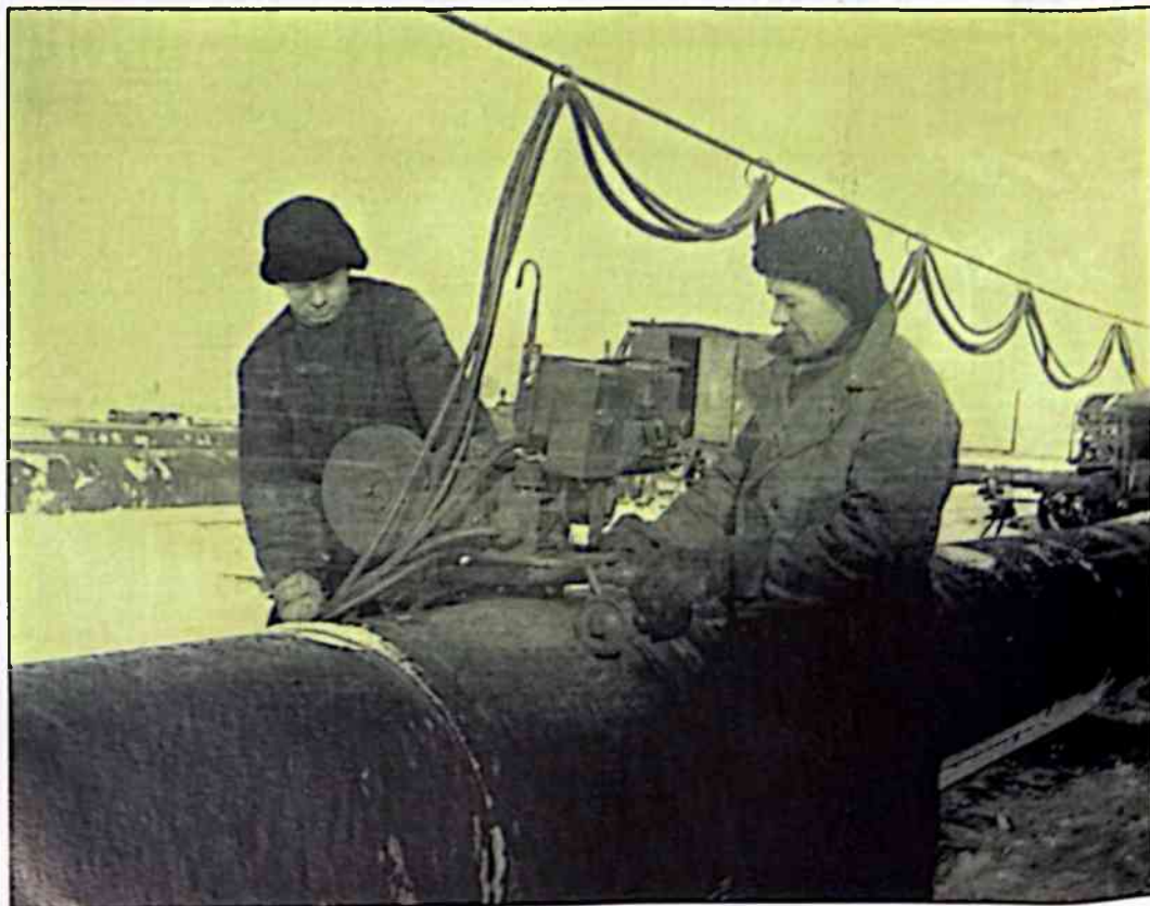
Сварка трубы нового газопровода.
