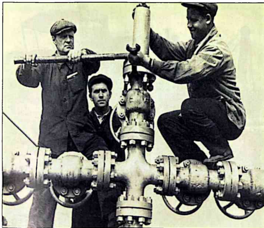
Оборудование газовой скважины.
