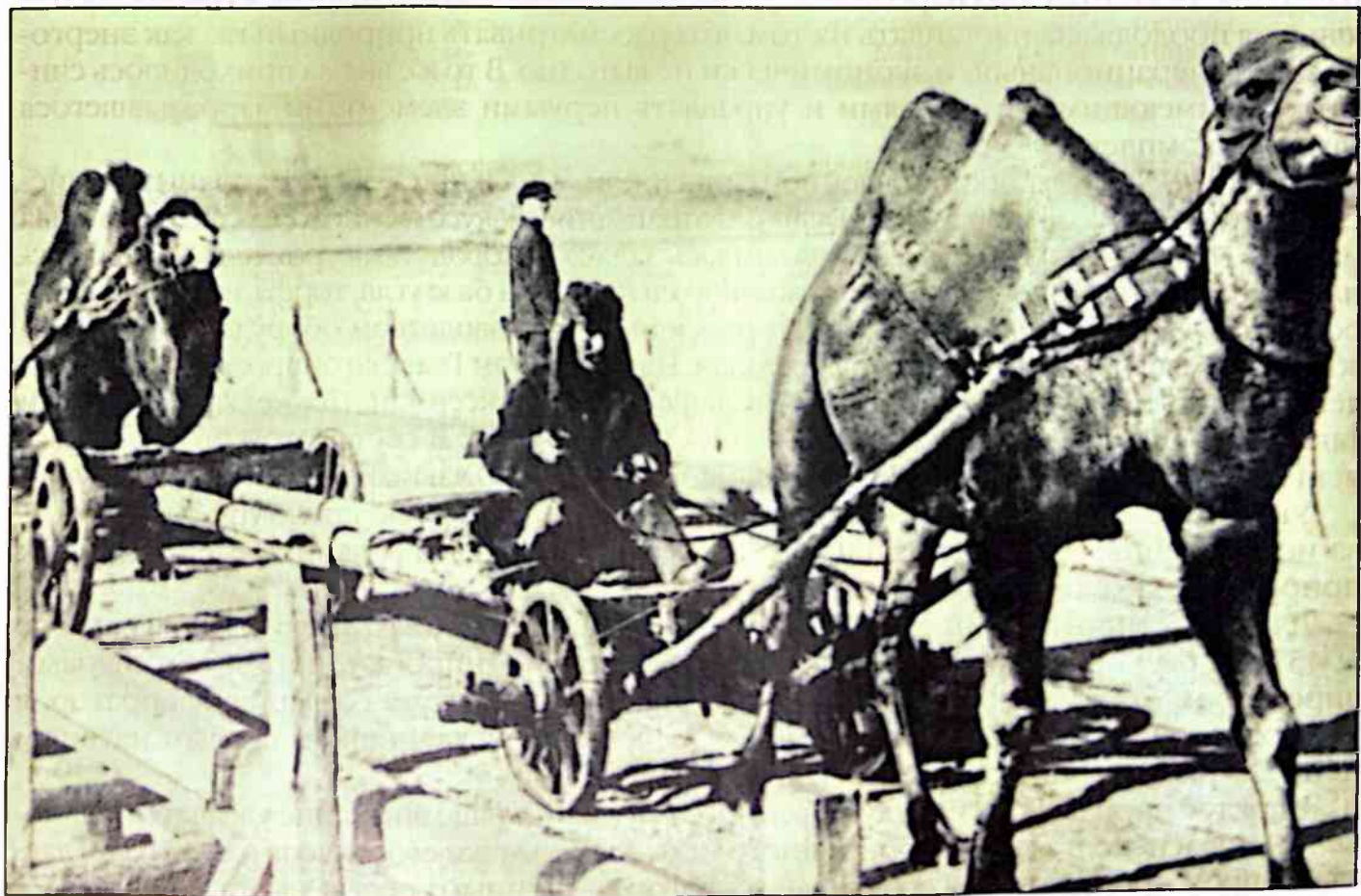
Доставка труб на трассу.
