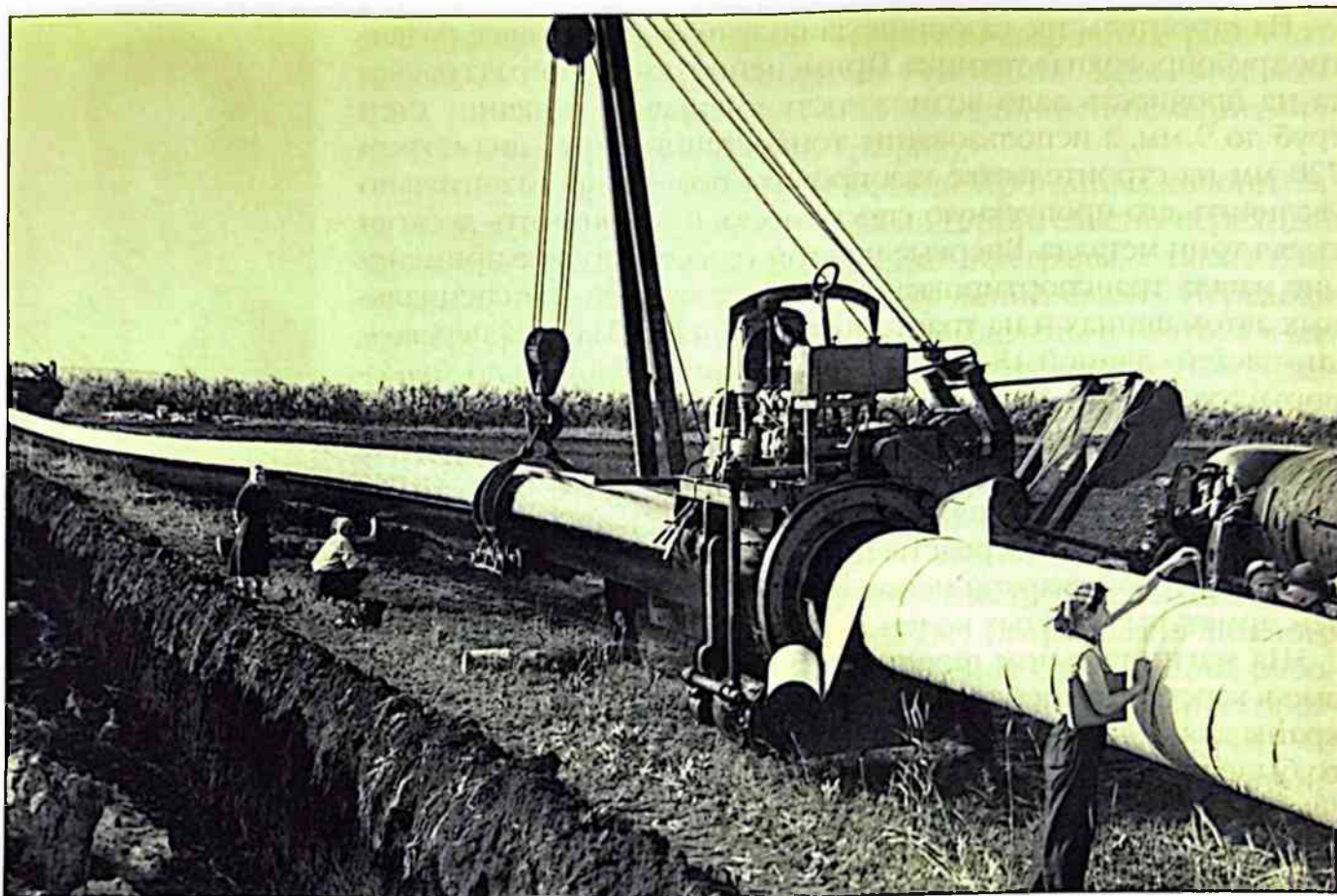
Изоляция трубы перед укладкой в траншею.
