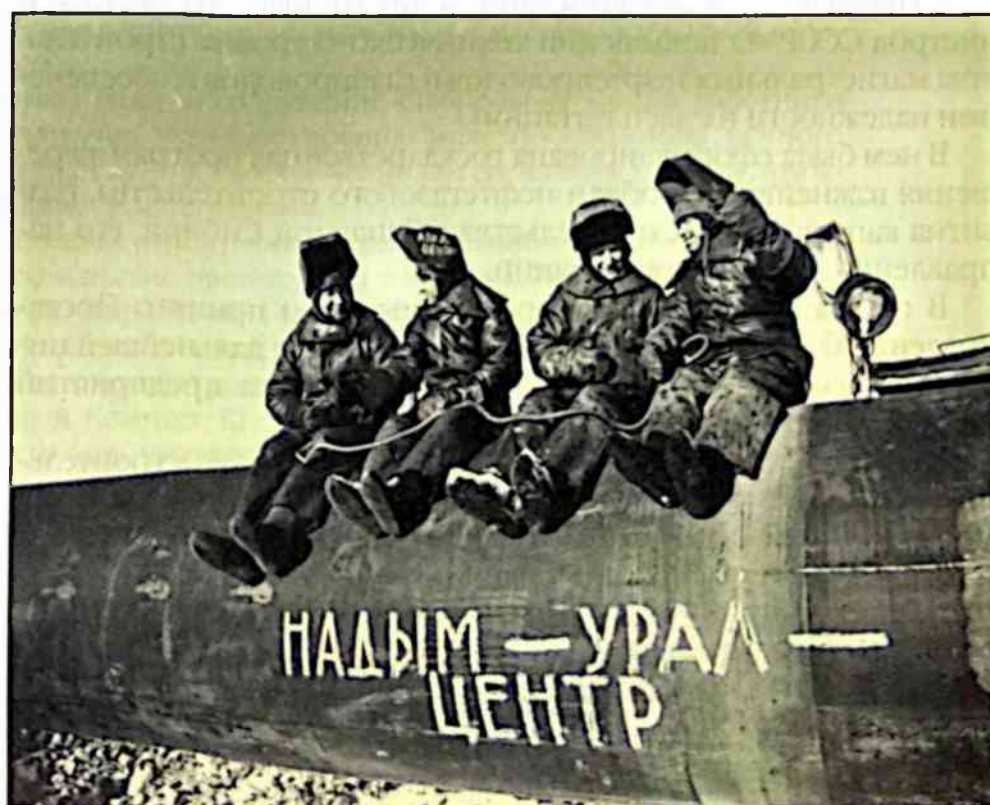
Сварен «золотой стык» газопровода СРТО — Центр.
