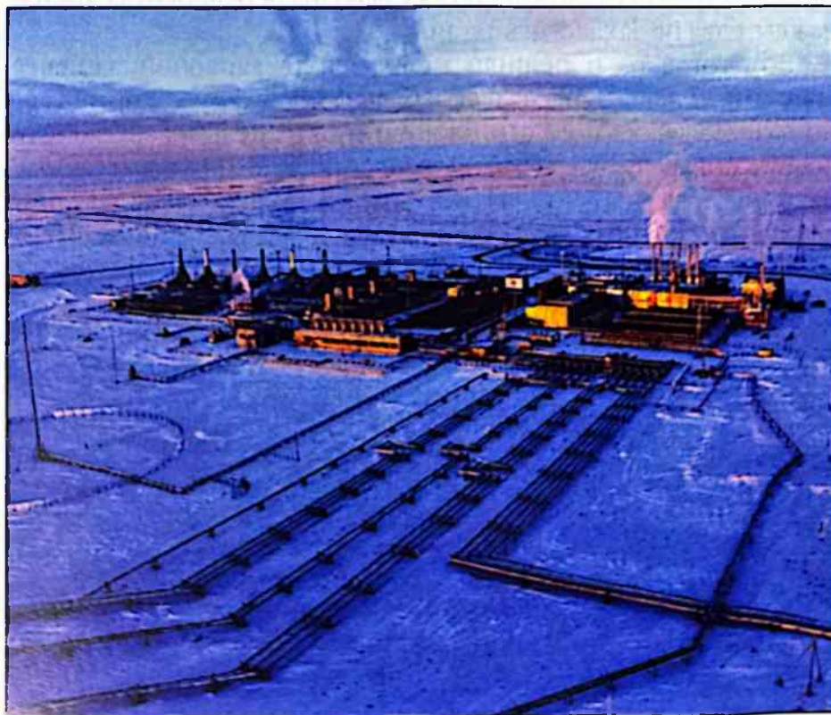
Установка комплексной подготовки газа на Ямбурге.
