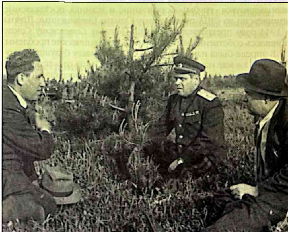
Ю.И.Боксерман и В.А.Пачкин на трассе строящегося газопровода.
