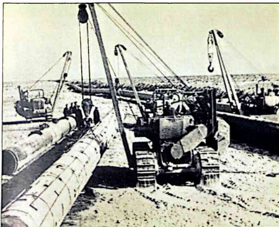
Трубоукладчики на трассе газопровода.
