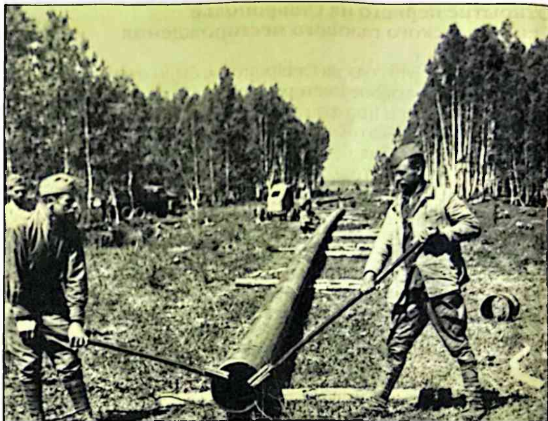
Подготовка трубы к сварке.
