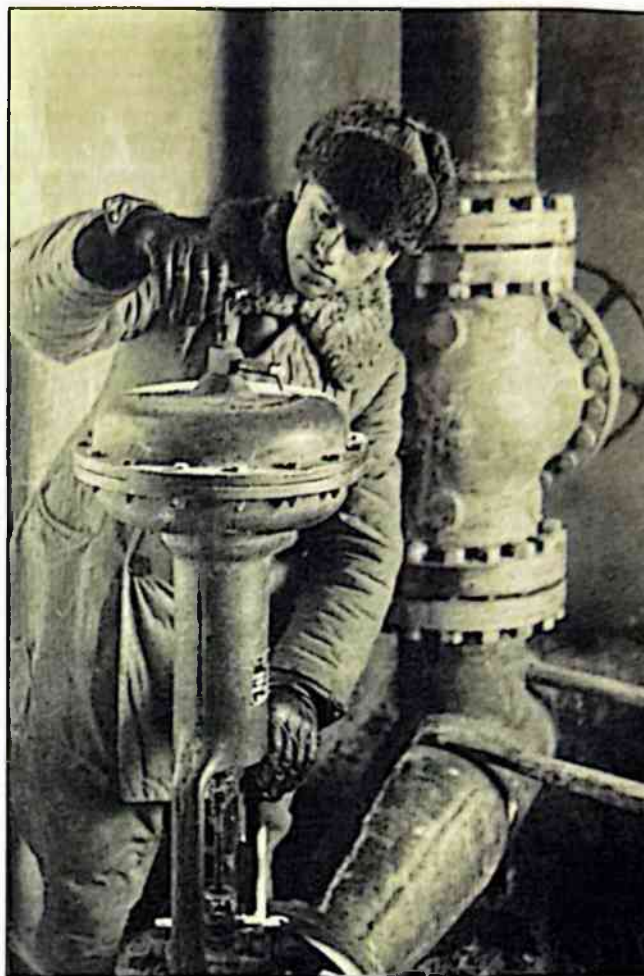
Пуск газа по новому газопроводу.
