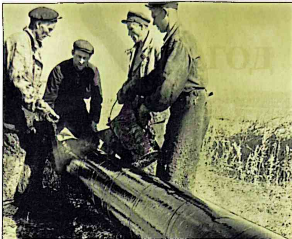
Покрытие мастикой трубы газопровода перед опусканием ее в землю (из архива С.М.Крайзельмана).
