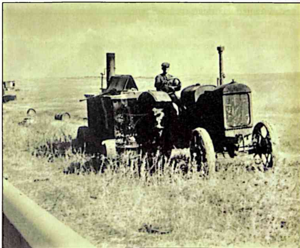
Вывоз мастики для изоляции на трассу газопровода (из архива С.М. Крайзельмана).
