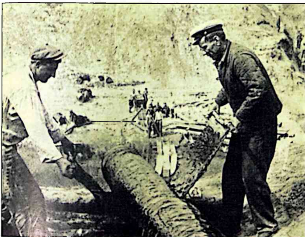
Изоляция первых газопроводов производилась вручную.
