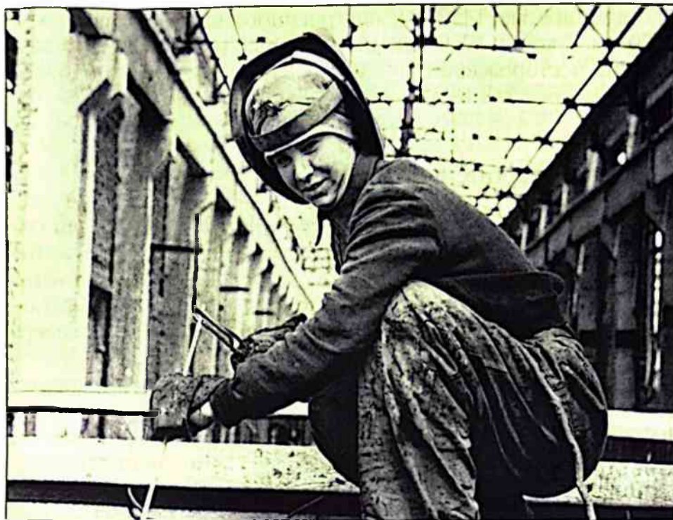
Строительство новых компрессор- ных цехов.
