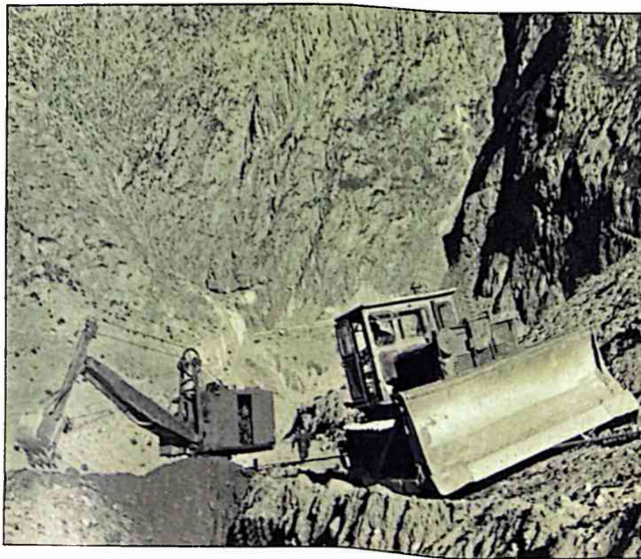
Подготовка трассы газопровода Орджоникидзе – Тбилиси.
