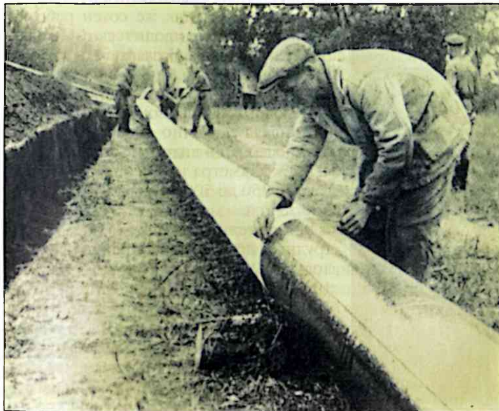
Покрывание трубы газопровода изолирующей мастикой.
