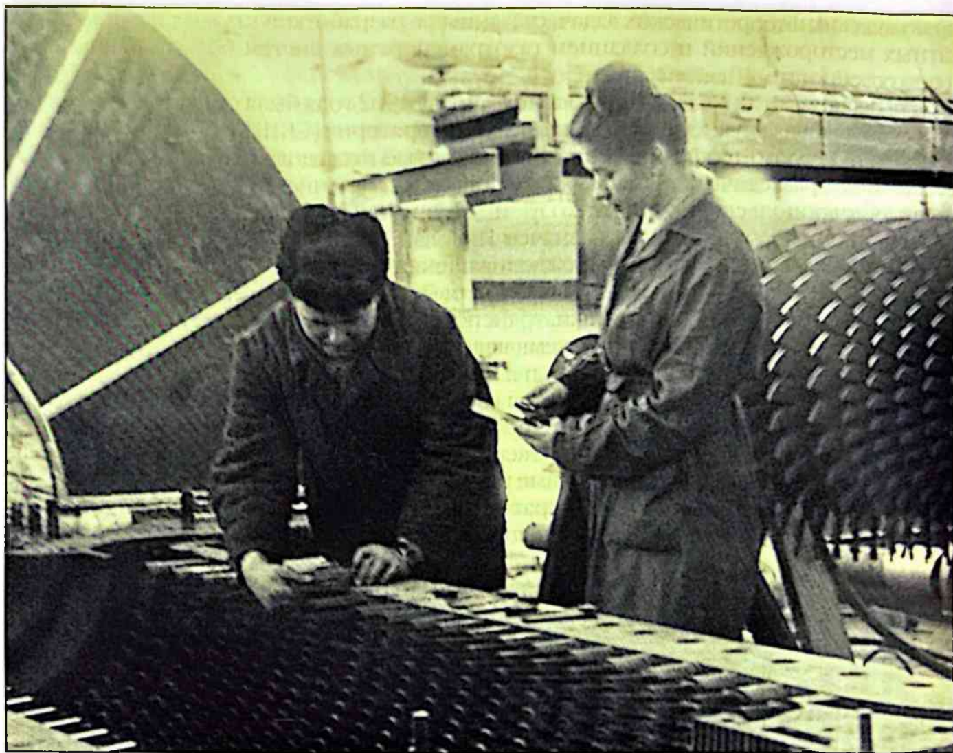
Ремонт газотурбинного агрегата.
