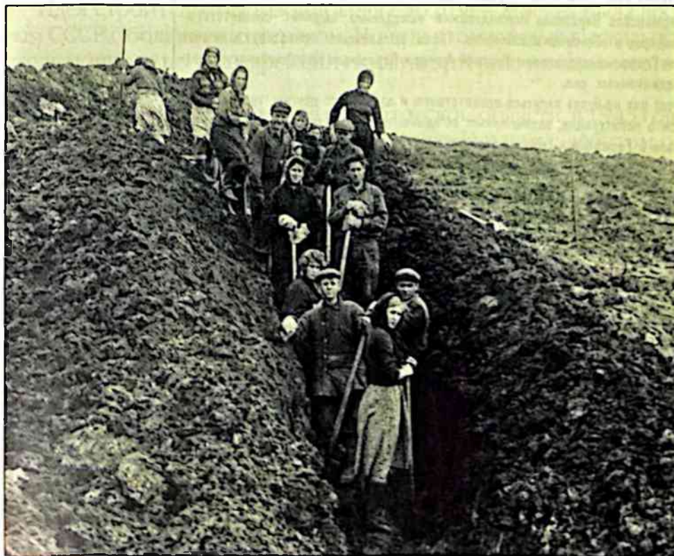
Отрывка траншеи нового газопровода.
