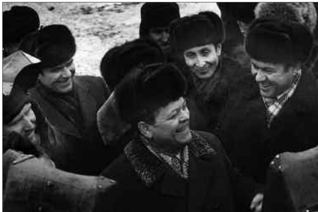
Душевный разговор в бригаде сварщиков на трассе газопровода. Тюменская обл., 1978 г.
