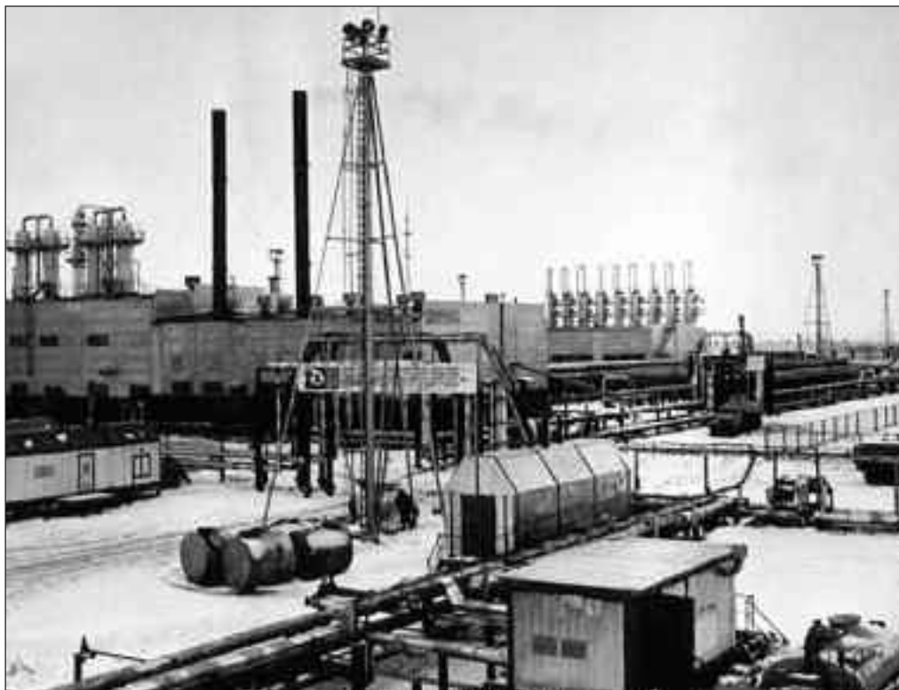
Установка комплексной подготовки газа. Ямбург, 1987 г.
