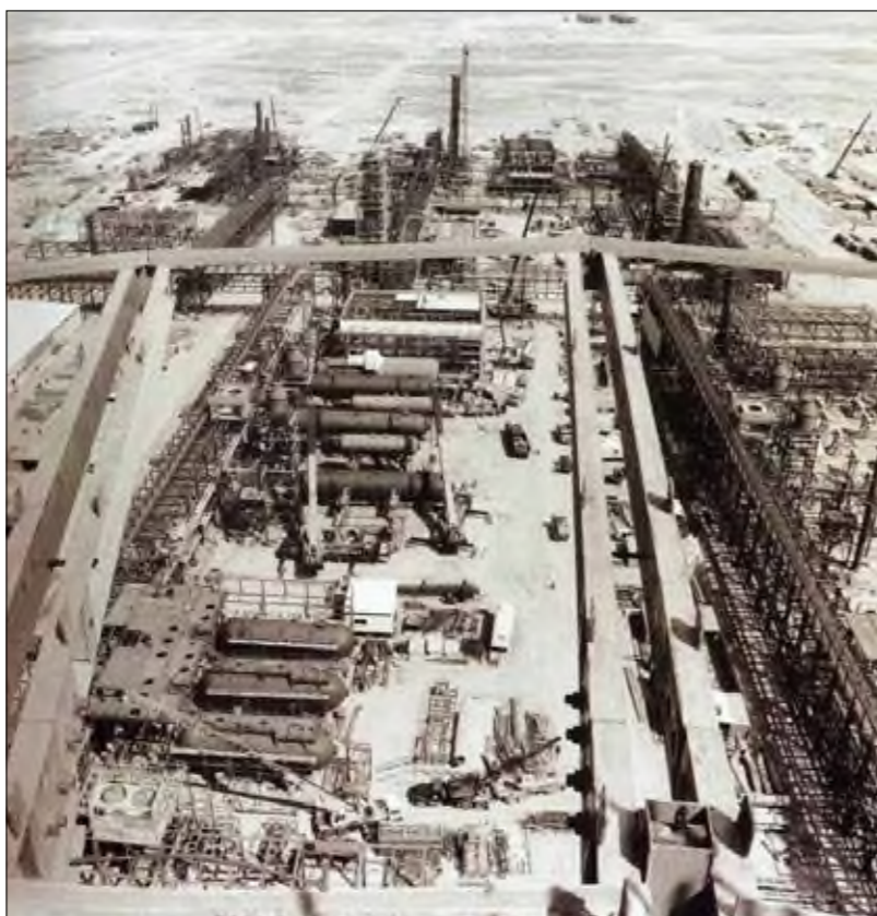
Строительство объектов нефтегазового месторождения Тенгиз (Казахстан)
