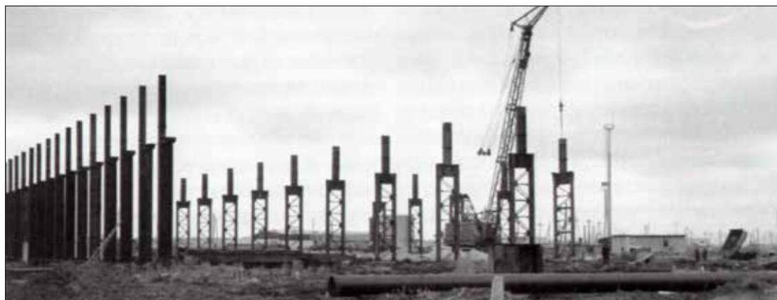
Так начиналось строительство завода комплектно-блочных устройств в Тюмени
