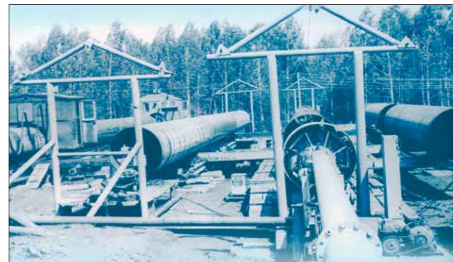
Изготовление сварочного стенда в одном из цехов ЦЭММ
