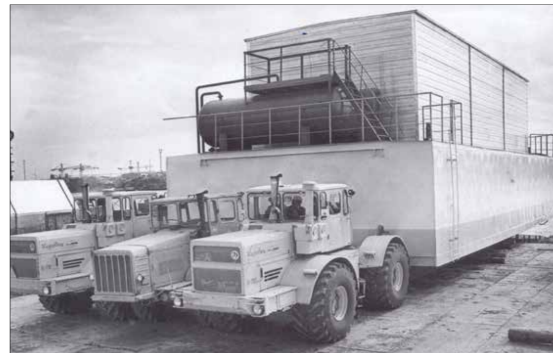
Суперблок блочной кустовой насосной станции
