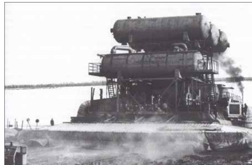
Транспортировка суперблока Дожимной насосной станции (ДНС) на платформе с воздушной подушкой
