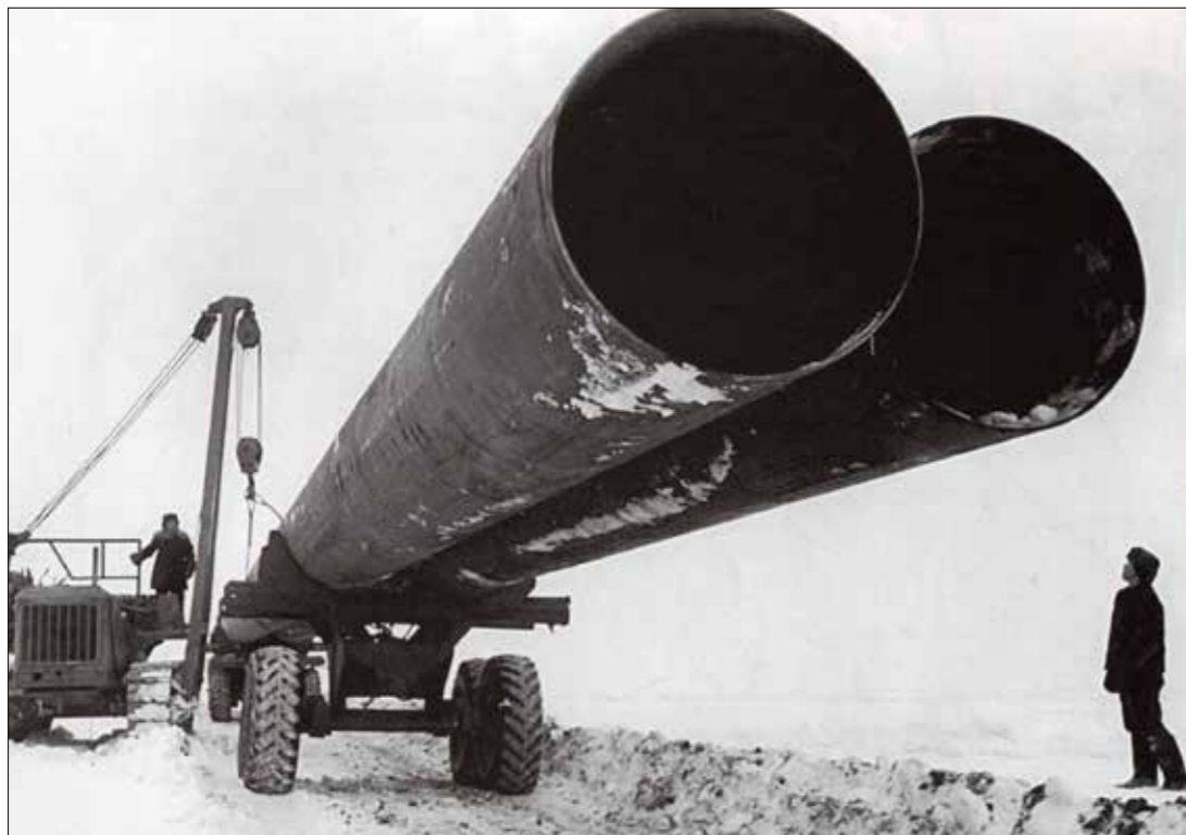
Вывозка труб на строительство газопровода Средняя Азия – Центр
