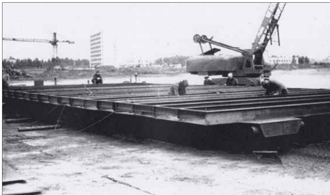
Тюмень. 1986 год. Сборка основания суперблока для Ямбурга
