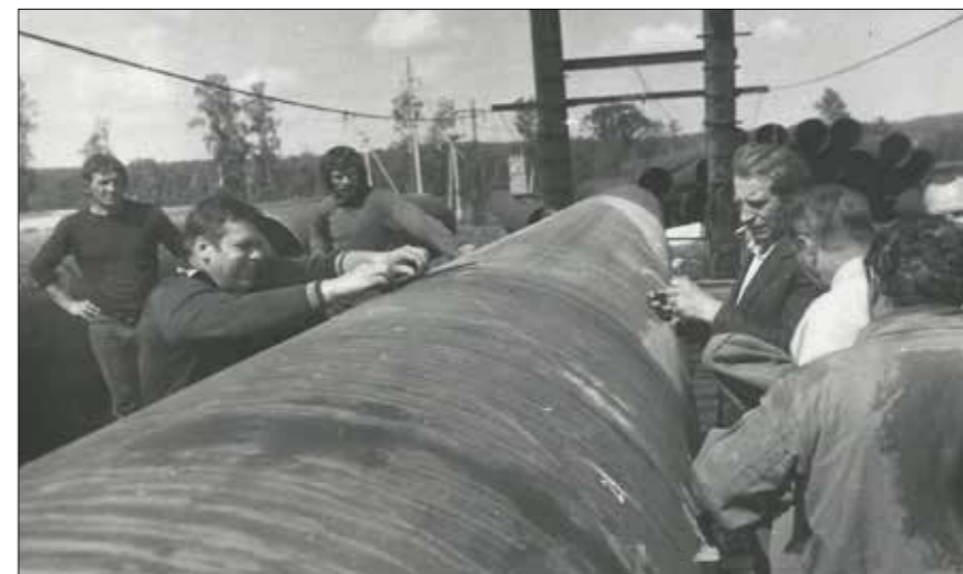
Конкурс профессионального мастерства сварщиков и дефектоскопистов Подразделений Главтрубопроводстроя на трубосварочной базе
