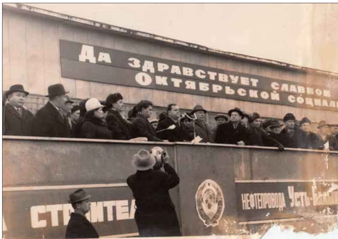
Октябрь 1967 года. Митинг на строительстве нефтепровода Усть-Балык — Омск
