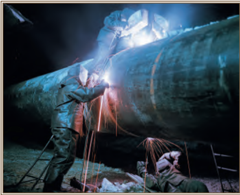
Ручная сварка ночью.
