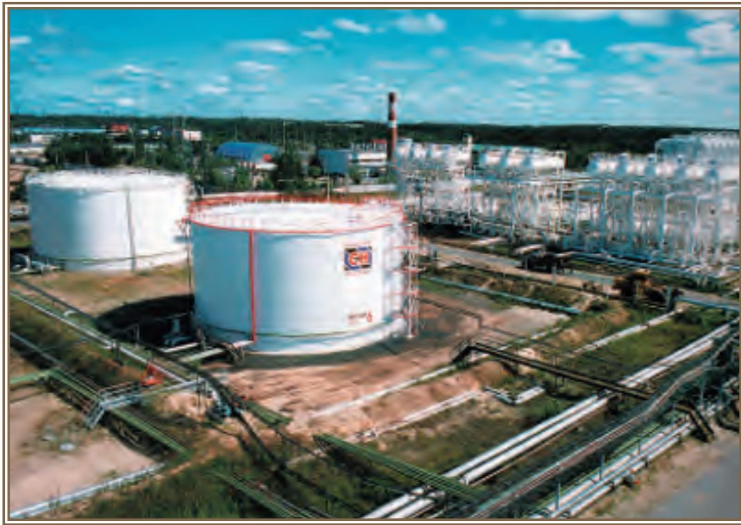
Южный резервуарный парк Самотлора, Тюменская область, 1990 год.
