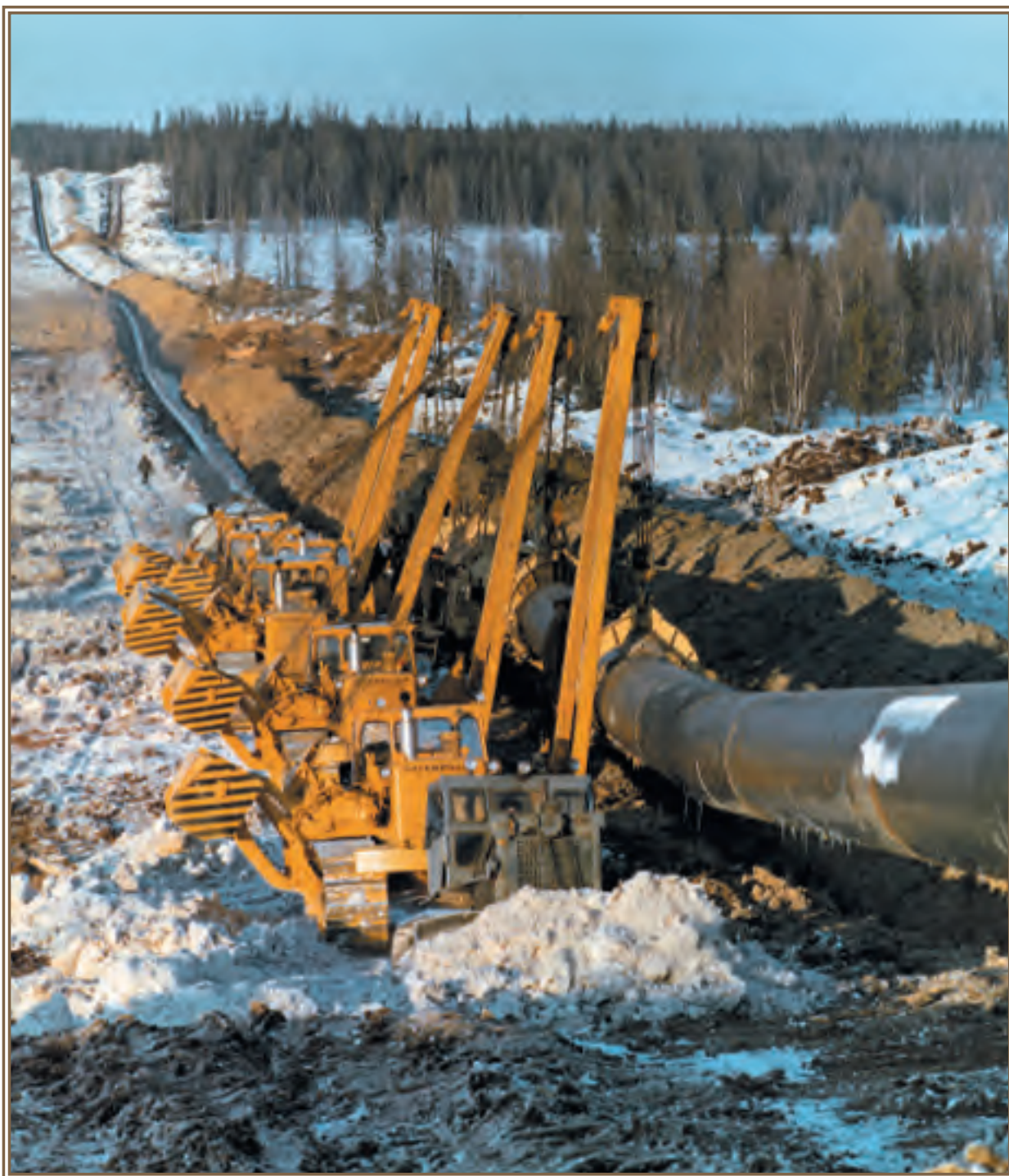
Изоляционно-укладочная колонна в работе.
