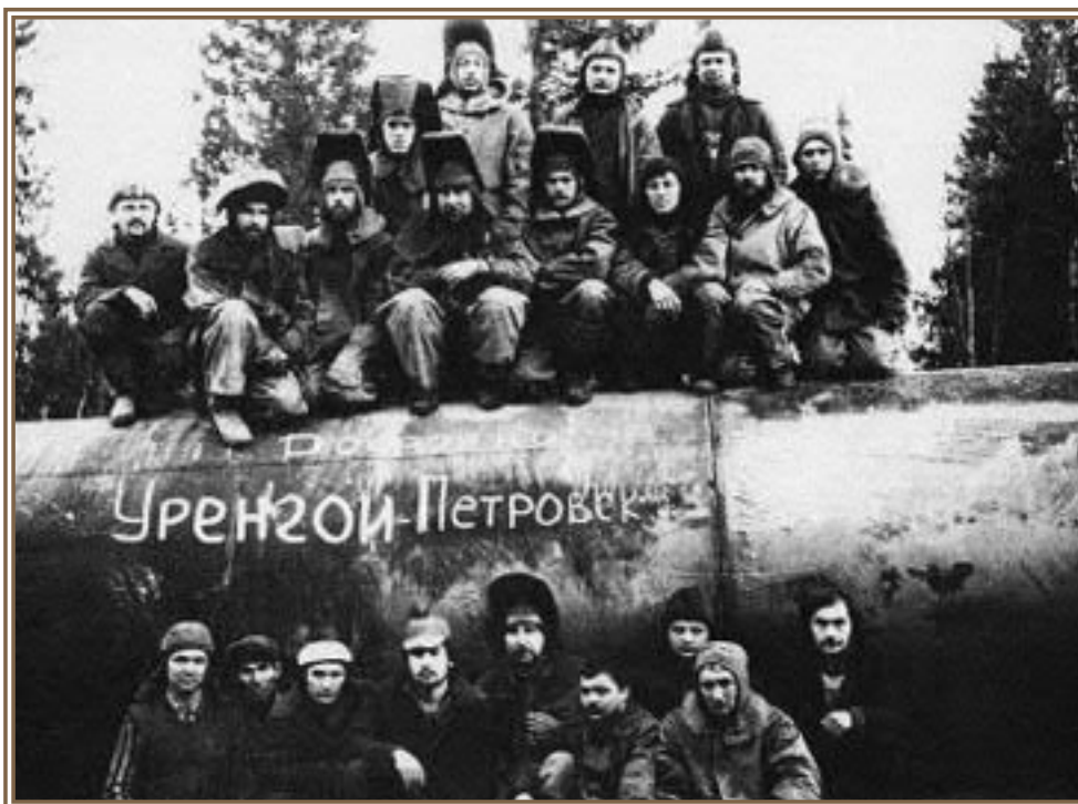
Рабочие треста Нефтепроводмонтаж на строительстве газопровода Уренгой – Петровск, 1982 год.
