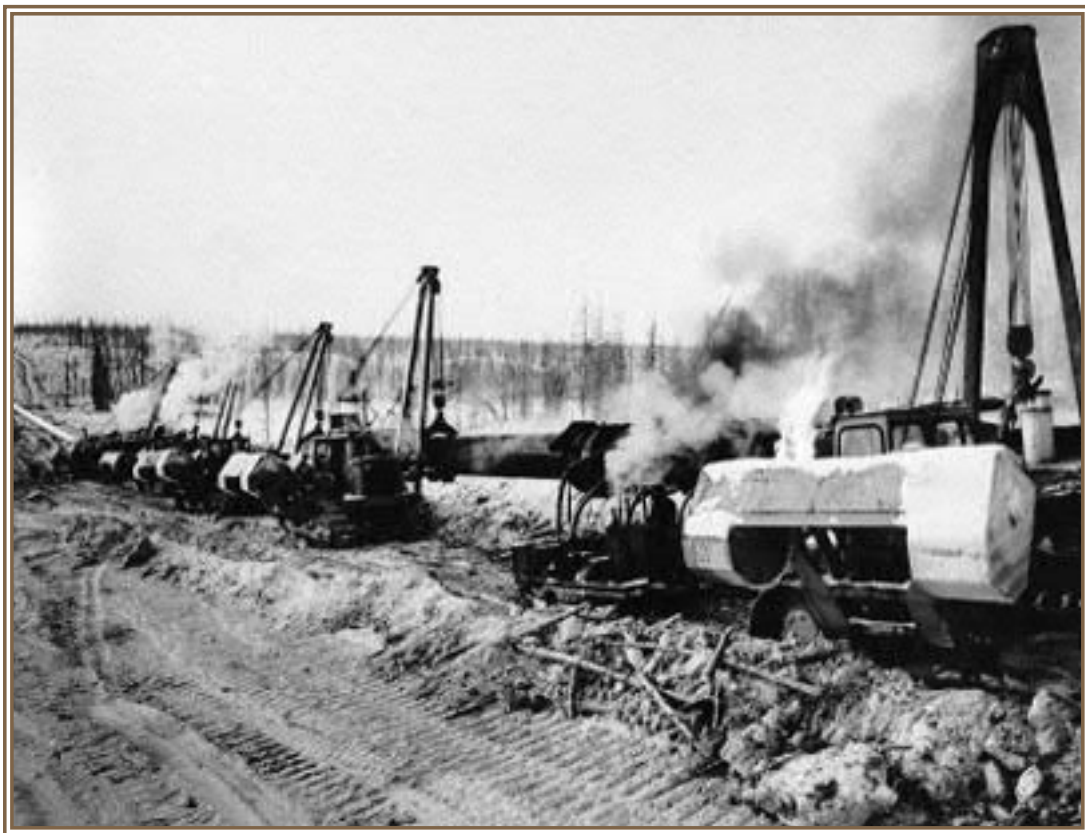
Изоляционно-укладочная колонна в работе, 1969 год.
