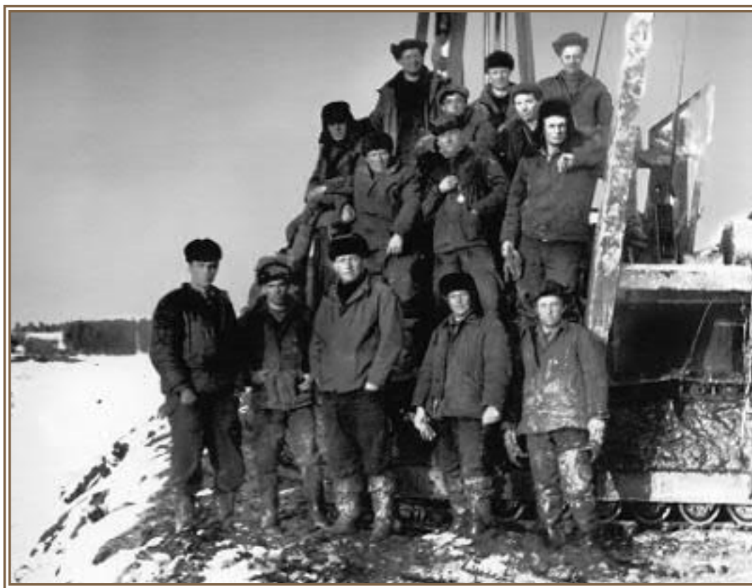
Строители нефтепровода Туймазы – Омск – Новосибирск, 1959 год.
