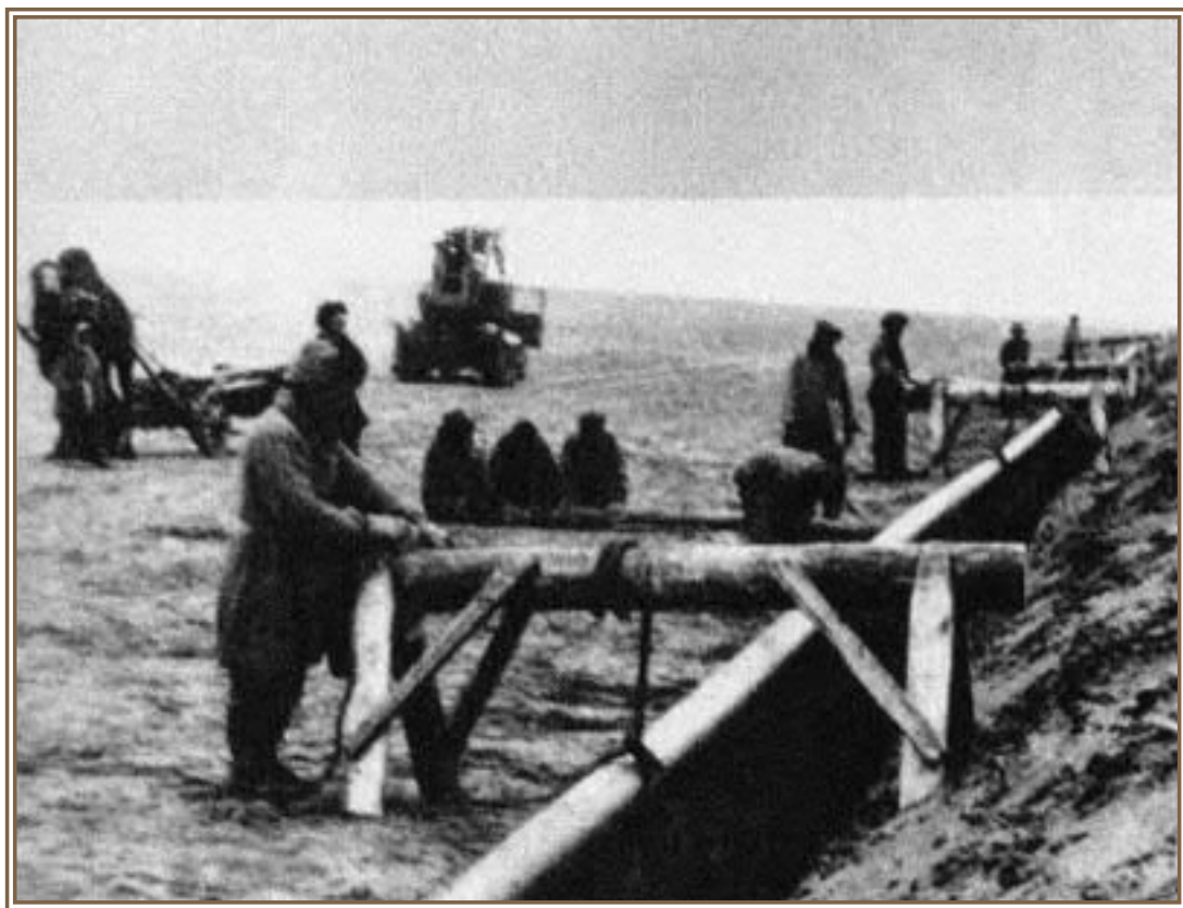
Опускание трубы в траншею. С этого начинали.
