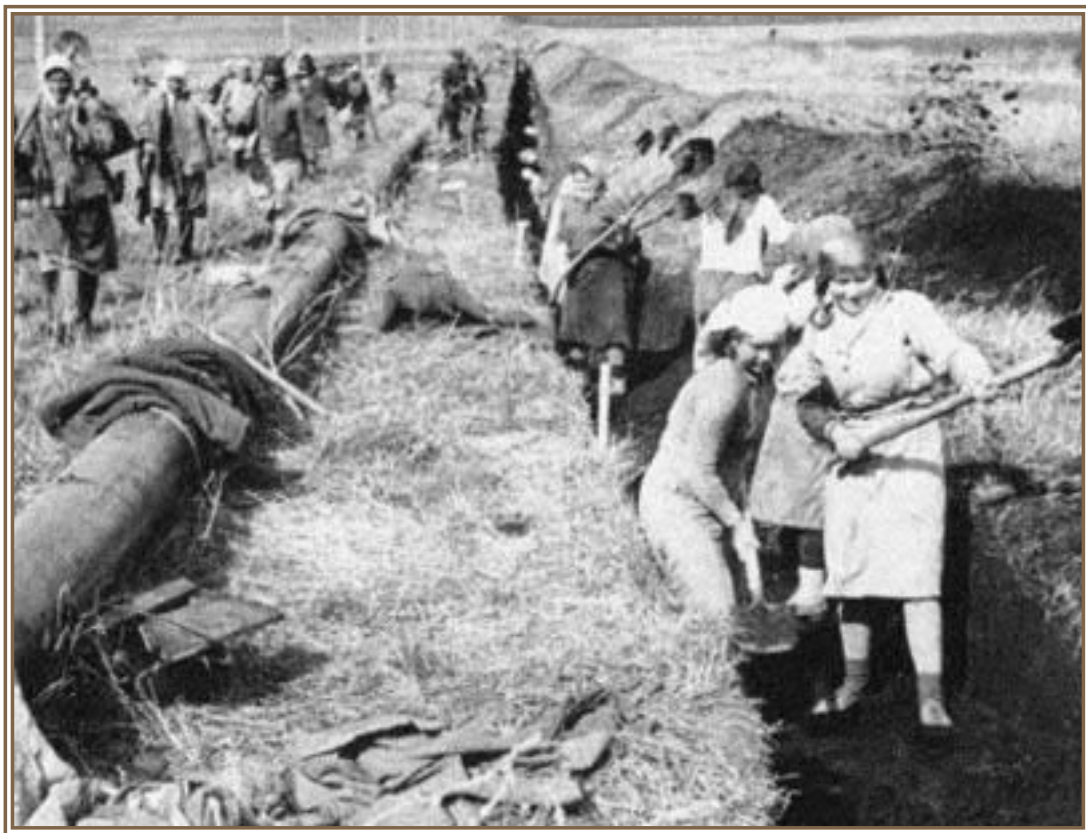
На строительстве газопровода Саратов – Москва, 1945 г
