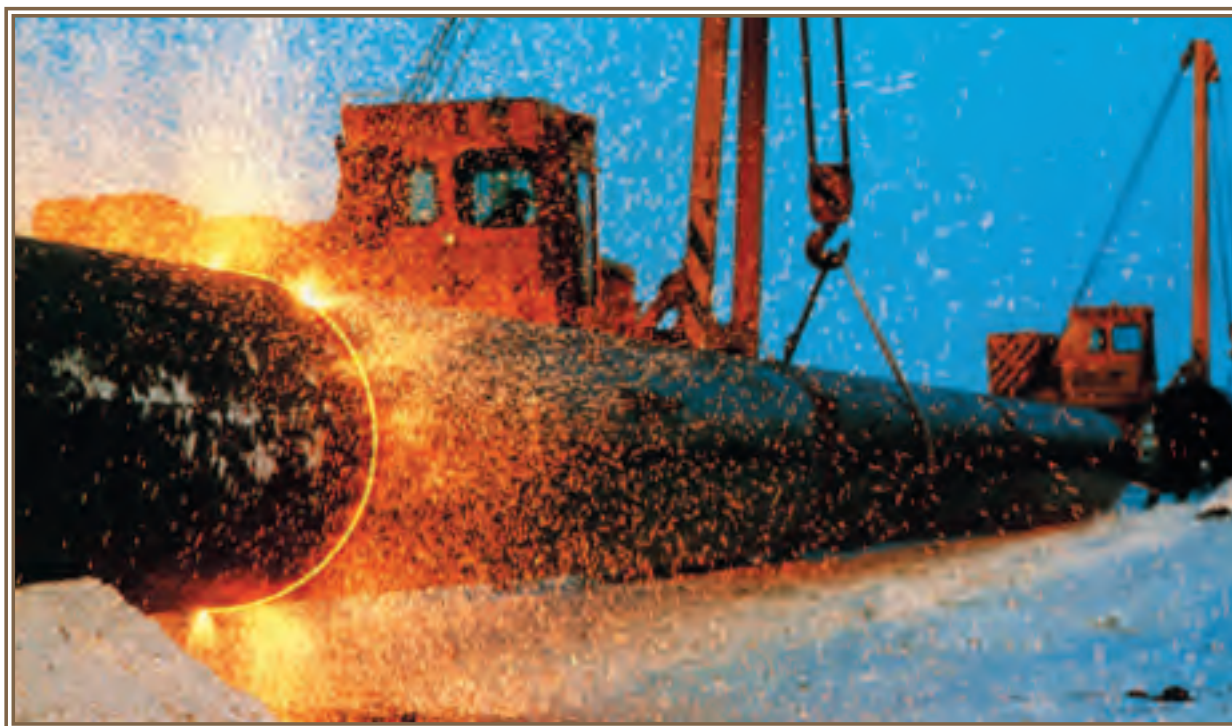
Сварочный комплекс «Север» в работе.
