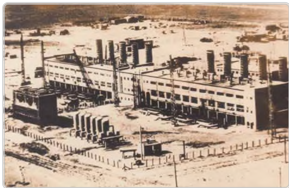
Внешний вид КС газопровода Средняя Азия — Центр
