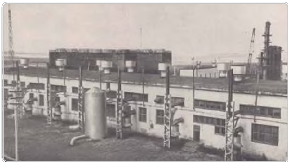
Компрессорный цех снаружи...
