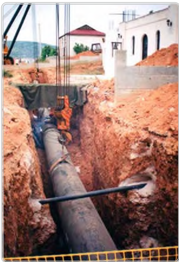
Монтаж захлеста в стеснённых условиях
