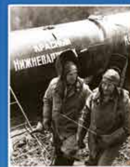
Н.А. Воробьев и Н.И. Кизуб среди строителей газопровода Надым – Пунга, 100 км которого впервые в мире были построены из труб диаметром 1420 мм. 1972 год
