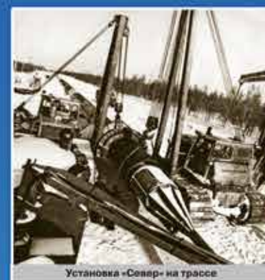
Установка «Север» на трассе
